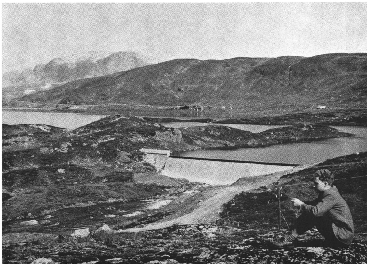
Fra Ståvatn som utnyttes i Tokke-anleggene
