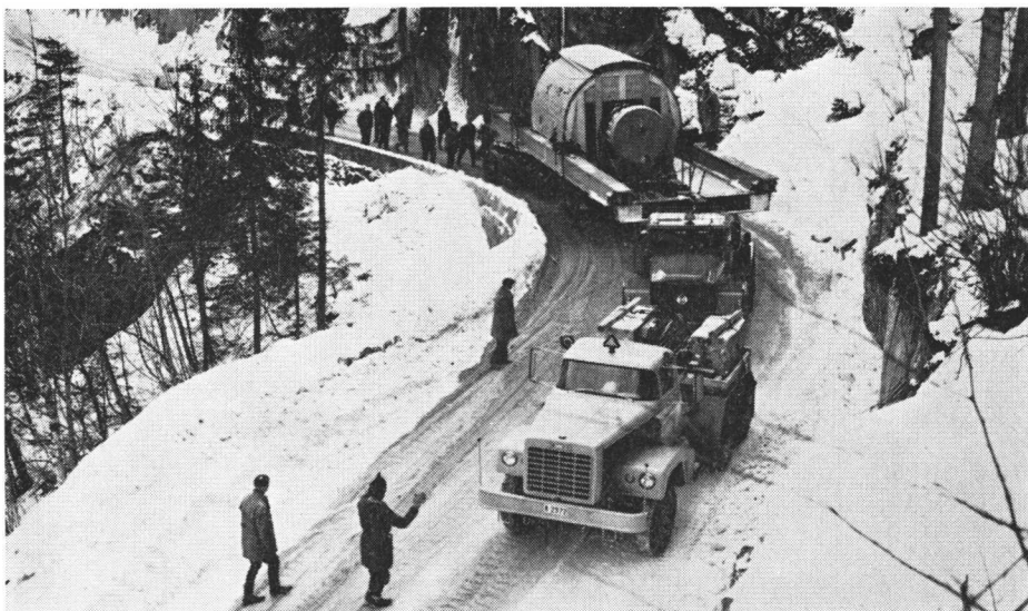
Fig. 14. Tokke-anleggene. Transport av rotor til Songa kraftverks generator (Tokke 3).
