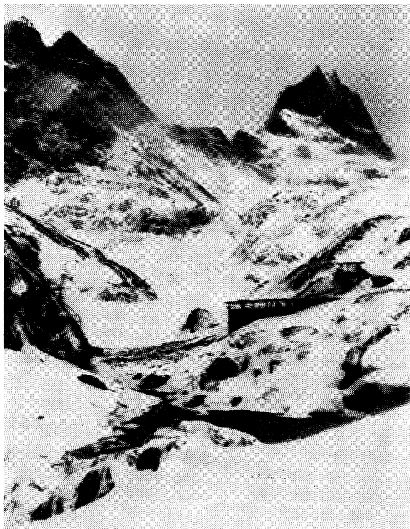
Fig. 4. Solbjørn kraftverk. Dam Solbjørnvatn under bygging.
