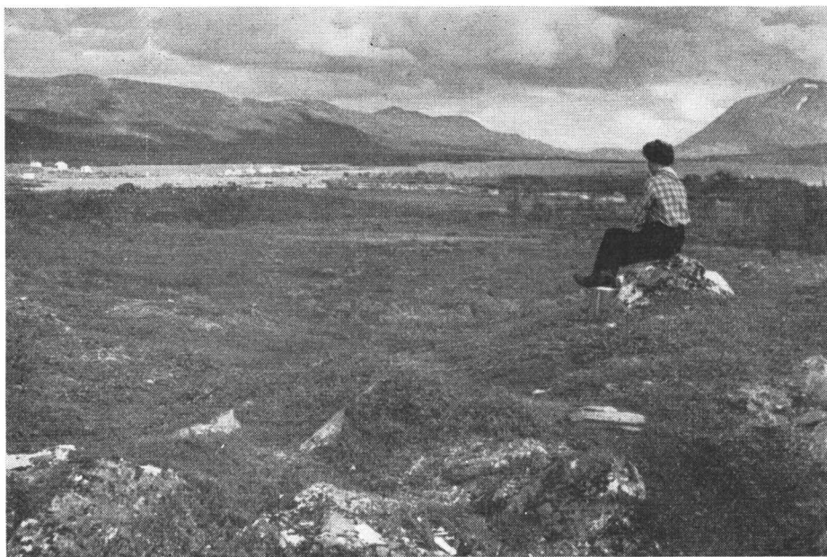
Fig. 18. Innset kraftanlegg. Fra Altevatn (vestre ende).
