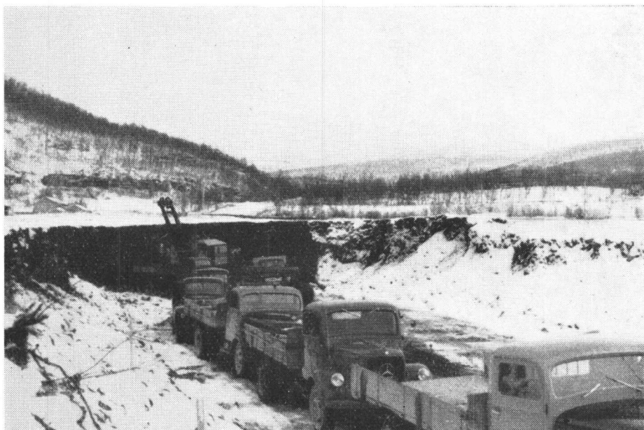
Fig. 24. Innset kraftanlegg. Gravningsarbeid undervannskanalen.
