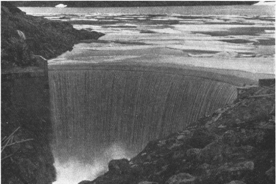
Fig. 8. Mårøyfjord kraftverk. Dam Reinkalvvatn.
