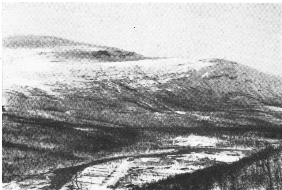
Fig. 21. Innset kraftanlegg. Kraftstasjonsområdet.
