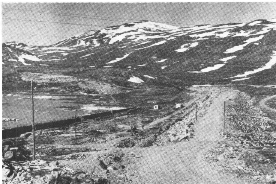
Fig. 13. Aura kraftanlegg. Osbudammen sommeren 1956.
