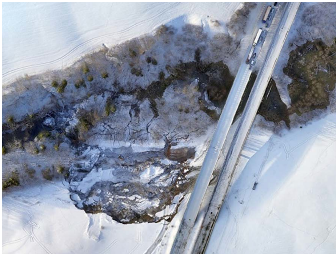
Figur 2.6 Skredet ved Skjeggestad bru på E18 i Vestfold utløst av fyllingsarbeider. Foto: Dronebilde, Orbiton
