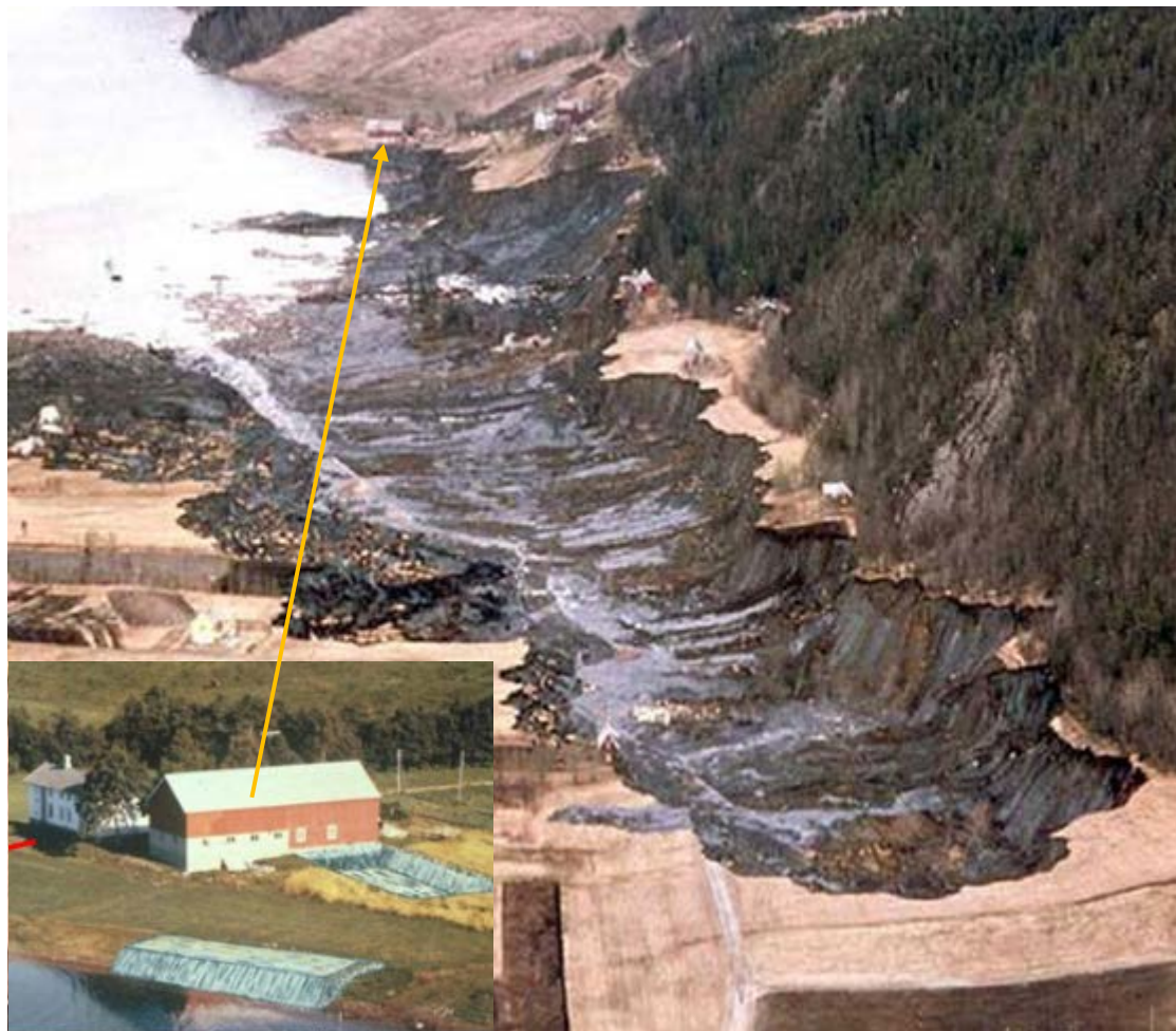
Figur 2.2 Rissaskredet 1978. Skredets utbredelse kommer frem av det store bildet. Innfelt bilde viser utgraving og oppfyllingen som forårsaket initialscredet, illustrert av Kjell Karlsrud, NGI. Foto: Adresseavisen
