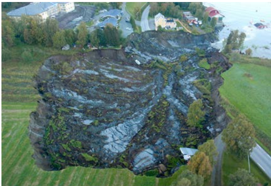
Figur 2.9 Kvikkleireskredet i Lyngen 2010 som utviklet seg retrogressivt fra et initialskred i strandsonen, Foto: Andrea Taurisano, NVE
