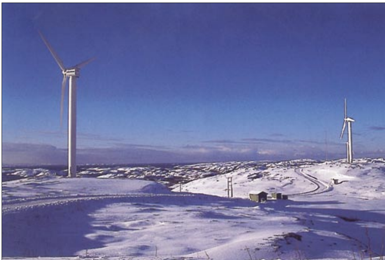
Vikna vindmøllepark i Nord-Trøndelag. Foto: Helene M. Berg, NVE
