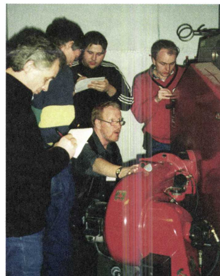
I fyrhuset til Oslo Energi i Drammensveien går Halvor Braathen gjennom alle sjekkpunktene for å regne ut virkningsgraden på en oljekjel.
