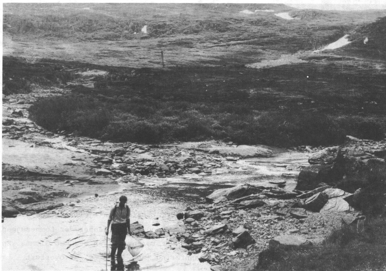
Fig. 12 Mørkedøla ved terskelbasseng nr. 4 før terskelbygging.
