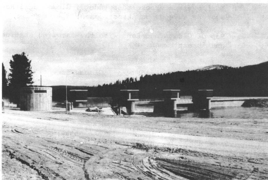
Fig. 15 Glomma ved Høyegga dam.
