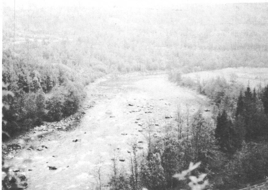
Fig. 18 Skjoma før bygging av terskler.
