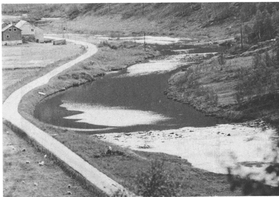
Fig. 2. Terskelbassenget på Ekse. The weir basin at Ekse.
