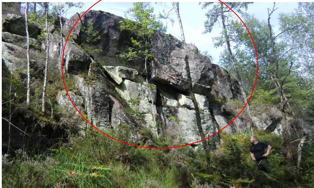
Foto 4: Ustabile blokker antydnet med rødt. Merk person til høyre i bilde som skala.
