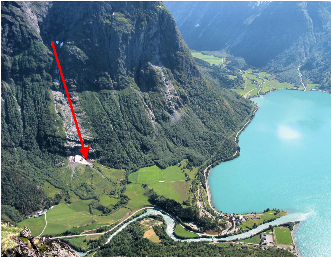
Figur 9. Hjelle og fjellsiden under Hjellehyenna. Skredløpet til Hjelleuksen er synlig til venstre i fjellsiden.
