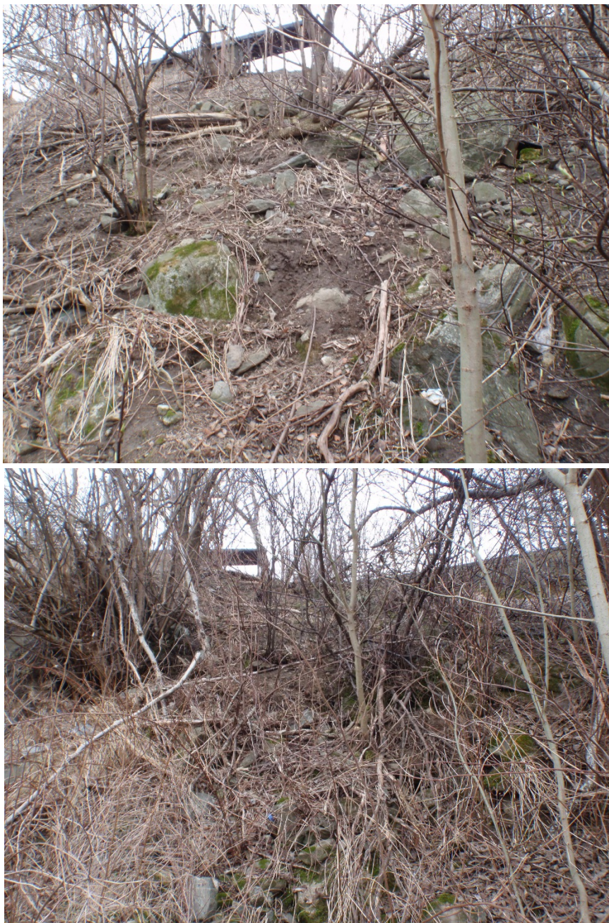
Figur 12. Ytstebøen 19. To oversiktsfoto av skråningen øst for eiendommen. Terrenget har her helning på ca. 43°. Skråningen består av en blanding av jord og stein (se også Figur 13). Dybden til fast berg er neppe særlig stor da fast berg i dagen finnes noen meter nord for løsmasseskråningen. For at eiendommen skal tilfredsstill sikkerhetsklasse S2 kreves sikring. Et mulig sikringstiltak er å renske vekk løst materiale i form av jord og steinblokker som kan tenkes å bli satt i bevegelse i det bratte terrenget. Utfall/skred kan for eksempel skje ved store nedbørmengder. Et annet mulig tiltak er å montere et fanggjerde lengre ned i skråningen. Det er mulig å plassere fanggjerde slik at fundamentering kan gjøres direkte i fast berg.
