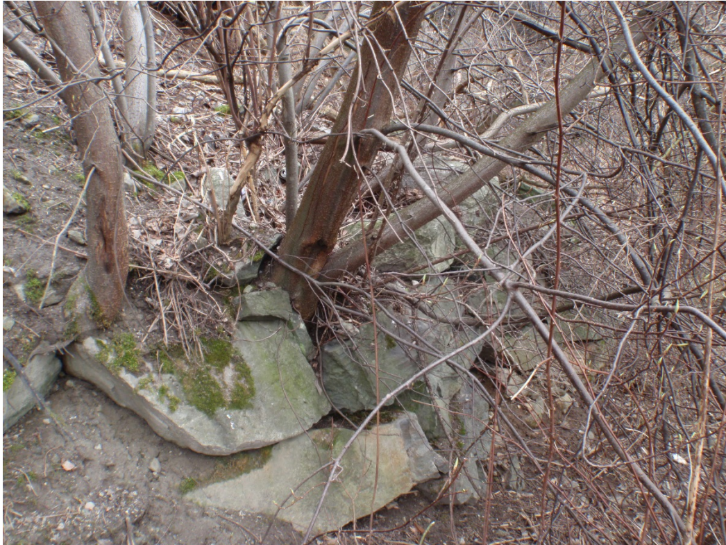
Figur 13. Ytstebøen 19. Detaljfoto av steinmur i skråningen øst for eiendommen. Steinmuren ligger på løsmasser. Rotsprengning må antas å foregå. Utfall herfra kan stoppe på ca. 2,5 m bredt relativt slakt hellende område på nedsiden, eller det kan fortsette videre ned skråningen og ned mot Ytstebøen 19.
