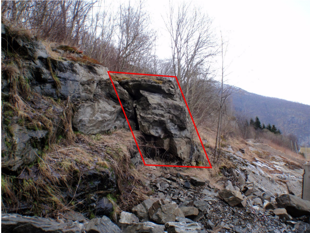
Figur 11. Ytstebøen 19. Detaljfoto sett mot sør. For at eiendommen skal tilfredsstillere sikkerhetsklasse S2 kreves at den markerte steinblokken enten fjernes (renskes ned) eller boltes fast.
