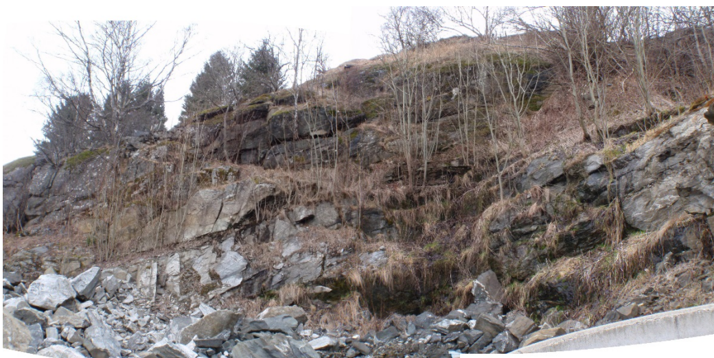
Figur 10. Ytstebøen 19. Oversikt sett mot nord. Bergskrenten er inntil 10 m høy og potensielle kildeområder for steinsprang finnes. For at eiendommen skal tilfredsstill sikkerhetsklasse S2 kreves sikringstiltak i bergskrenten. Trolig vil rensk og spredt bolting, eventuelt stedvis kombinert med fjellbånd, være tilstrekkelig. Dog kan det bli aktuelt med en barriere i form av liten fangvoll eller fanggjerd i lav energiklasse nært skråningsfoten. Eventuelt behov for barriere vurderes etter sikringsarbeid i selve bergskrenten.
