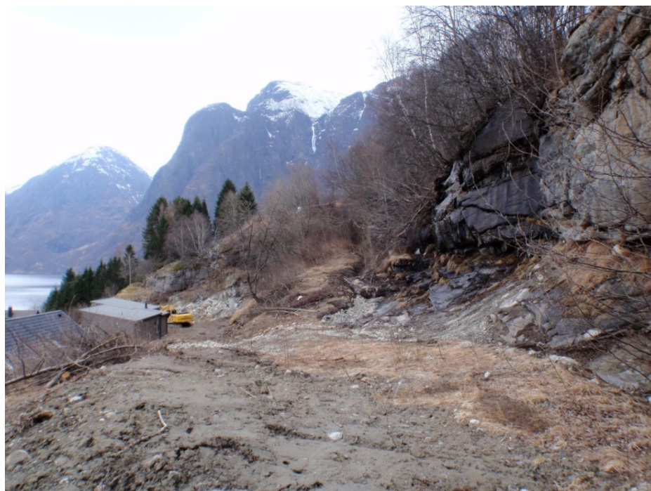
Figur 7. Oversiktsfoto tatt nord for Ytstebøen 11, og sett mot nord-nordøst. Deler av bergskrenten som utgjør potensielt kildeområde for steinsprang ses til høyre i bildet. Den gule gravemaskinen er plassert på Ytstebøen 19.
