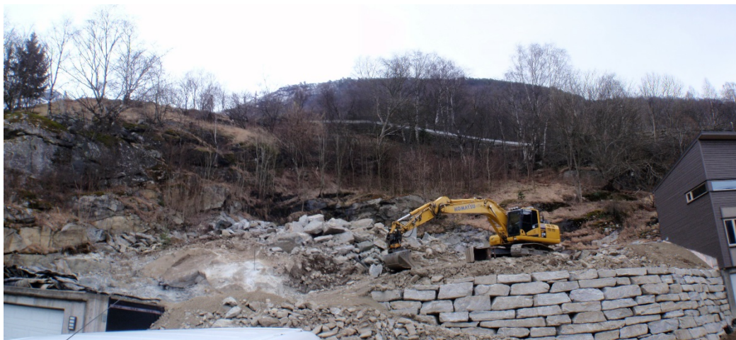
Figur 9. Ytstebøen 19. Oversikt sett mot øst. Grunnarbeider pågikk under befaringen. Bratt bergskrent ses til venstre (nord), bratt skråning ses i bakgrunnen (øst) og deler av Ytstebøen 17 ses til høyre (sør).
