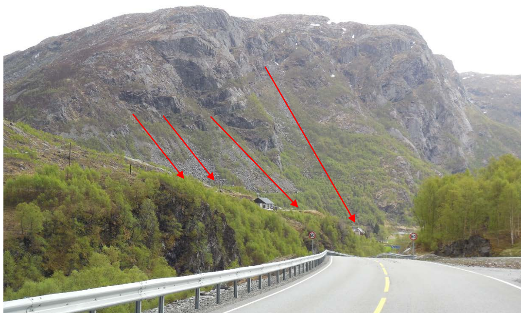
Figur 19 Fjellsida ovenfor Byrkjedal kan gi opphav til snøskred langs flere baner som går ned mot bebyggelsen på Moen (vist med piler)
