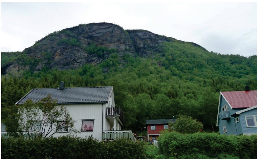
Figur 12 Stup med oppsprekking og overheng ovenfor Torsvika
