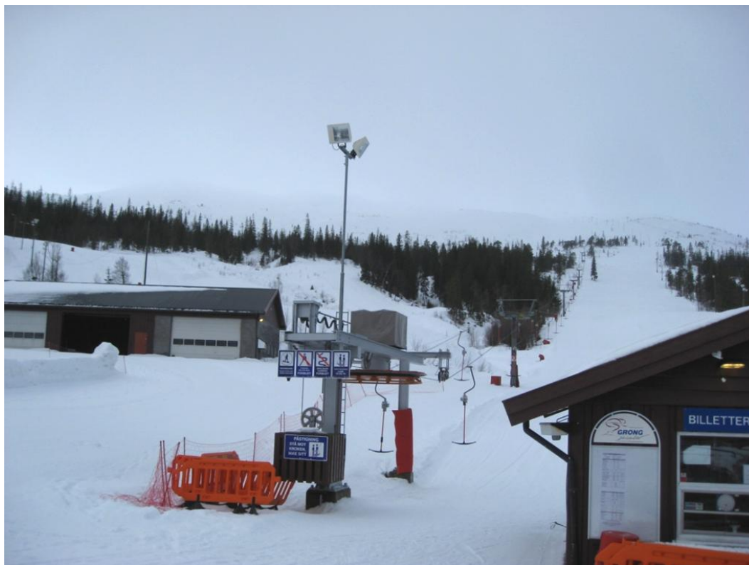
Figur 6 Fra bunnstasjonen sett oppover i alpinanlegget. Både snø og sørpeskred kan gå ned i forsenkningen til høyre for verkstedsbygningen med retning heisen.
