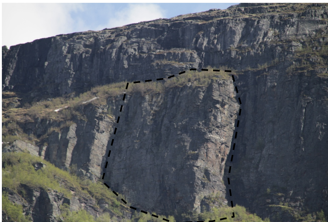
Figur 6. Bildet viser det største løse bergpartiet i fjellsiden ovenfor Lofthus (Stiplet strek). Ujevne nær vertikale sprekker er også synlige på midten av partiet.
