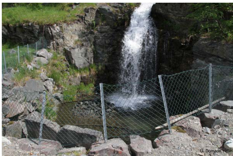
Figur 9. Sedimentasjonsbasseng i Lofthusbekken like ovenfor gårdsbebyggelsen på Lofthus.
