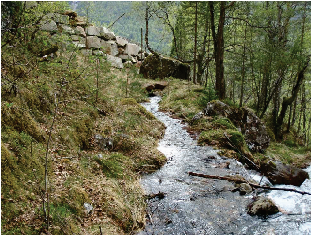
Figur 10 Ovanfor vollen er det bygd ei sikring på omlag 3 meter høgd
