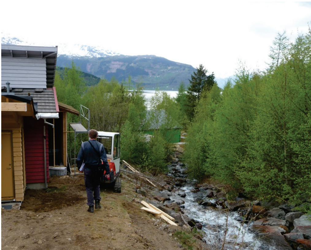
Figur 11 Bekken har liten plass nedanfor sedimentsjonsbassenget og går tett opp mot hus.
