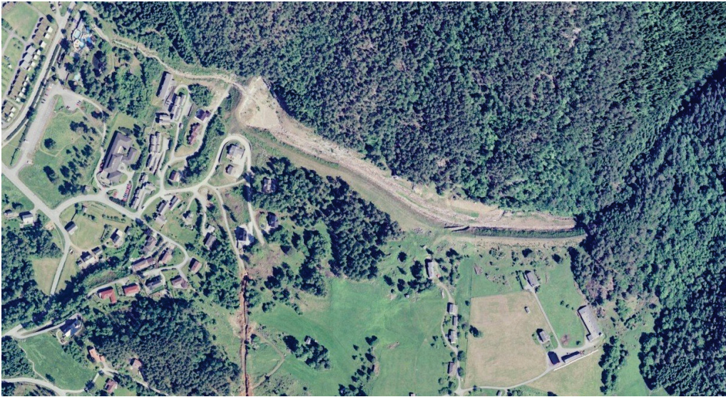
Figur 2 Flyfoto av flaumskredvollen med sedimentasjonsbasseng og busetnaden nedanfor.
