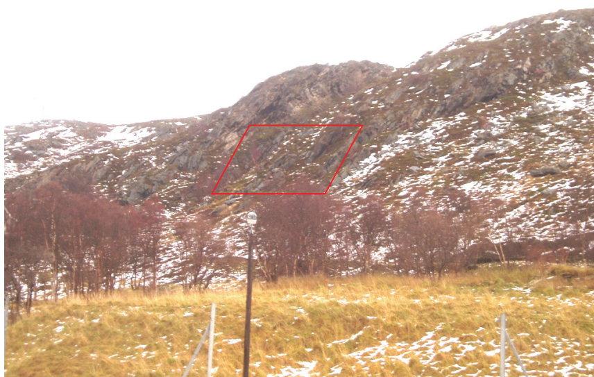
Foto nr 4. Utløsningsområde for steinsprang og mindre snøskred i fjellryggen mot Svartvannsbekken
