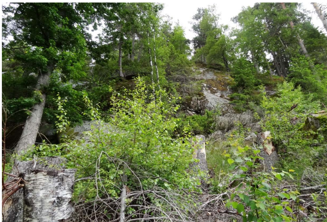
Figur 11. Nærfoto av berget bak bolighusene i område A24.
