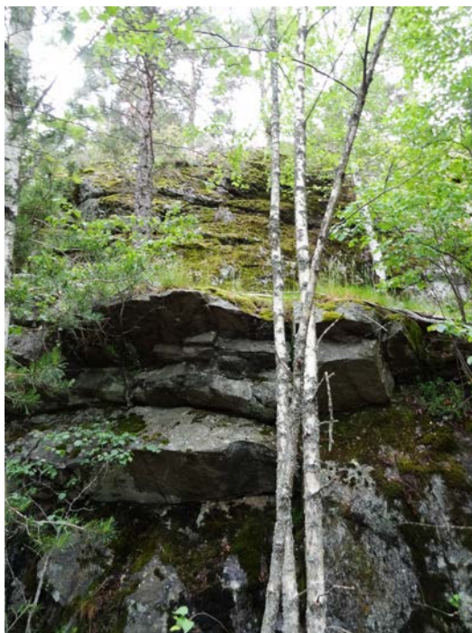
Figur 4. Løse blokker over vei (pkt. 1 i kart 01).
