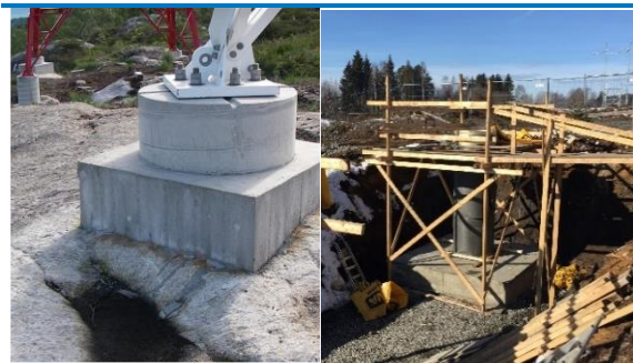
Figur 2-1. Eksempler på fjellfundament (venstre) og jordfundament (høyre).
