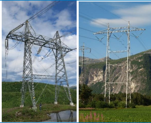
Figur 2-2. Eksempler på forankringsmast (venstre) og bæremast (høyre)
