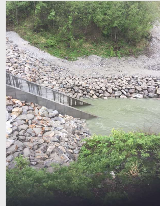
Flomsikringsanlegget i Kvam. (OED)
