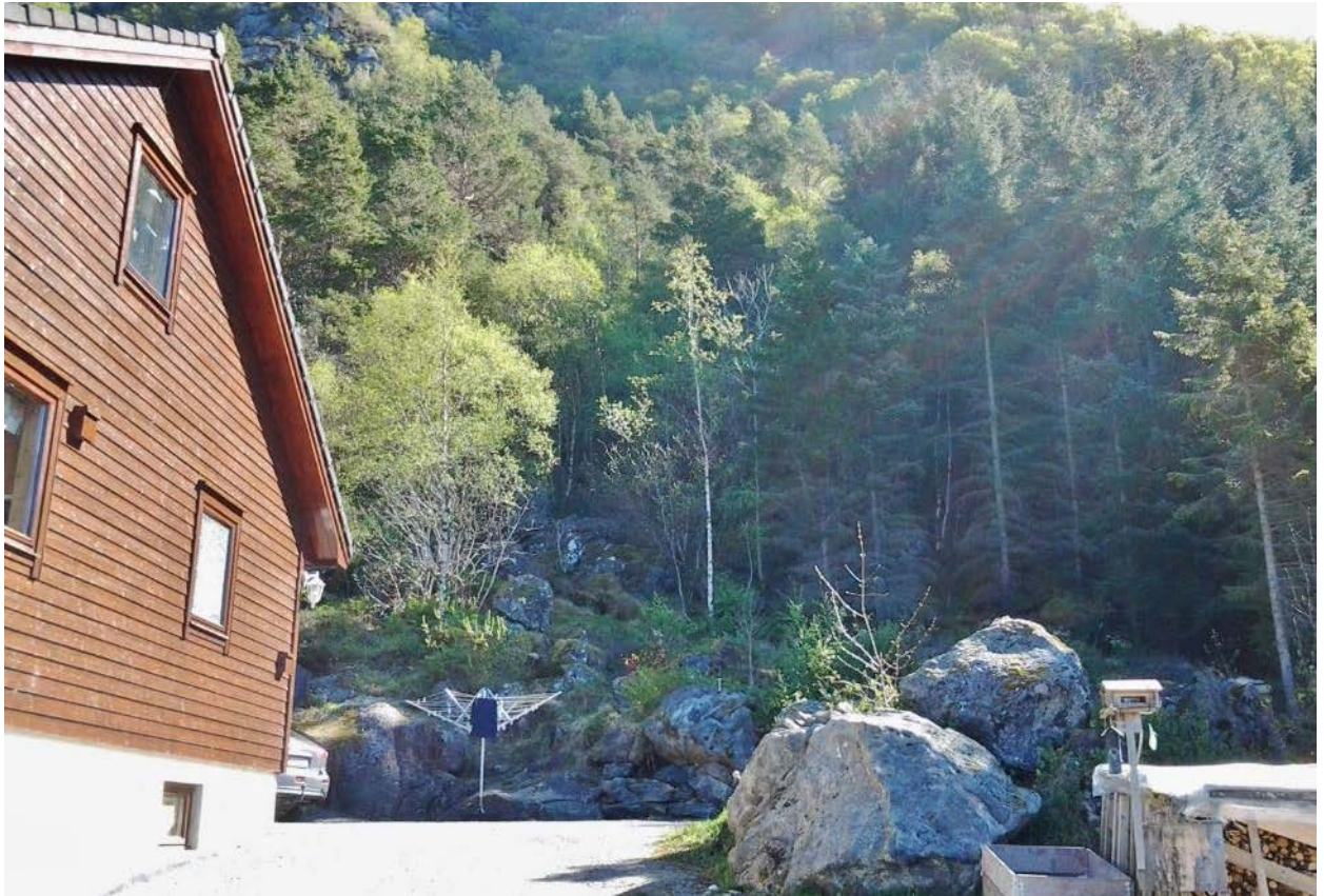
Figur 3: Mye steinsprangblokker i hagen ved et hus sør i området, øverst i Kvernhusvegen. Ura strekker seg ned til huset.
