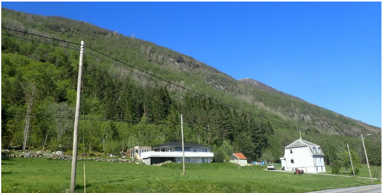
Figur 6 Potensielle mindre løsneområder for steinsprang mellom Nybø og Engeset.
