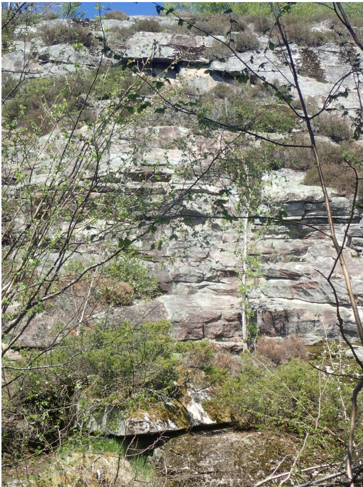
Figur 13 Lokal brattskrent mellom Skogtun og Brattli som kan gi kortere utfall, med underliggende ur.
