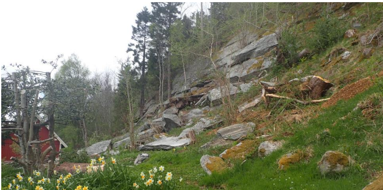
Figur 25 Løsneområde og steinsprangavsetninger øst for Fjell-ly.
