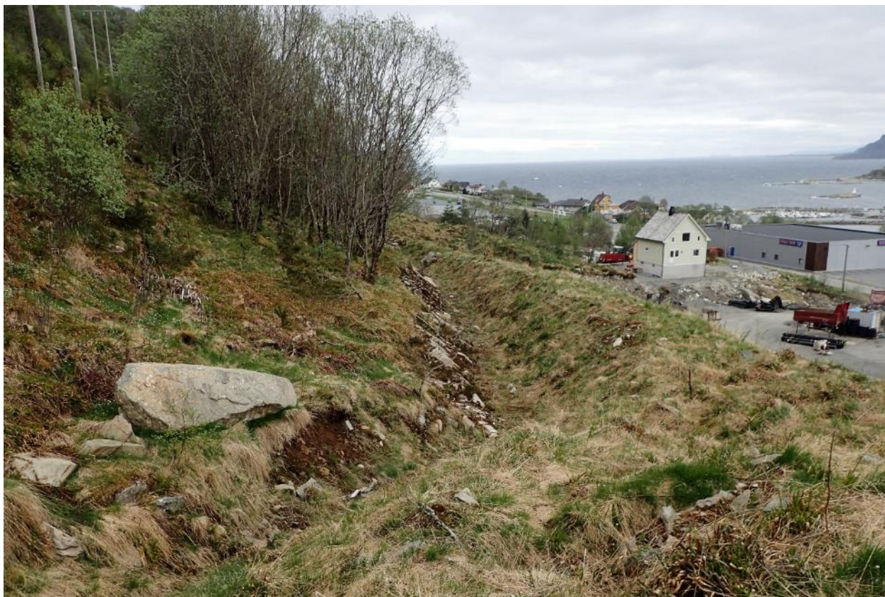
Figur 5: Løsmassevullen over byggegroppa sett fra oversiden.
