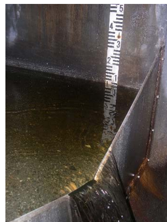
Figur 27 Profil og resterande instrumentering med loggar, snøsmeltekar og trykceller er lokalisert under bakken. Tilkomst via kumlok.
