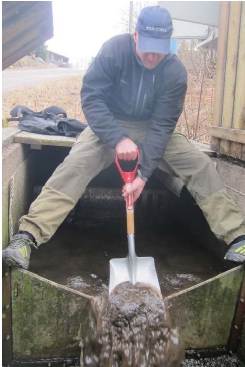
Figur 11 Fjerning av sediment frå overløpet.
