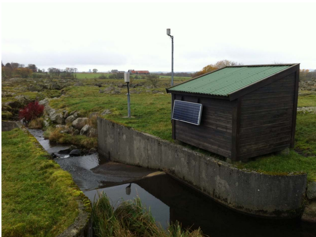
Figur 16 Bilete over Lye 2 urbanstasjon, med nedbørmålar, lufttemperatursensor og crump-overløp
