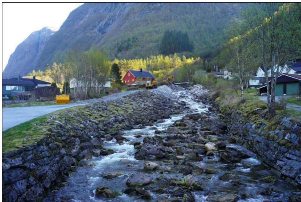
Fig. 6.5.1.3. Nedre del av Kråkelva sett fra brua markert med A på kartet Fig. 6.5.1. 2. NVE-Anlegg reparerer sikringen fra 70-80-tallet nedenfor det røde huset ( C på kartet). Stein og blokk i elveløpet viser et høyenergetisk elveløp med betydelig erosjonsevne. Foto: Terje H. Bargel, april 2014.
