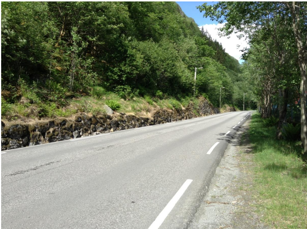
Fig. 4.4.1.3. Bilde er tatt fra vegen ved industriområde øst for Hjetland. Det har her blitt fjernet steinsprang avsetninger for bygging av veg. Skråningen mot vegen er forsterket med støttemur av blokker.
