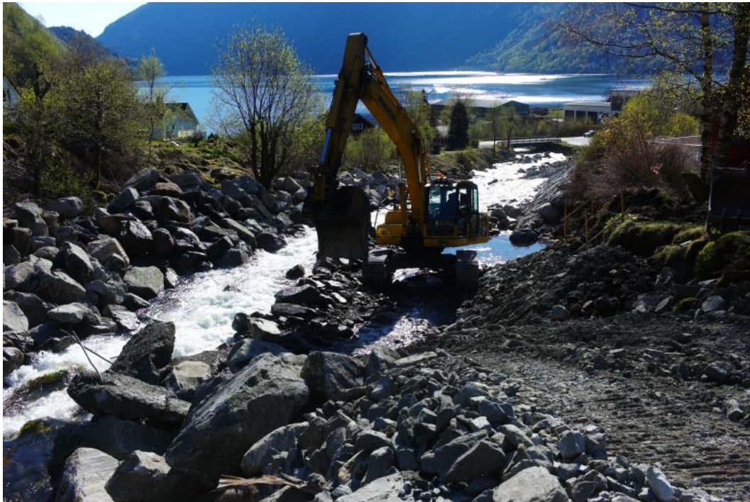
Fig. 6.5.1.4. NVE utfører reparasjonsarbeid/forsterkning av elveforbygningen like nedenfor det røde huset (markert med C på Fig. 6.5.1.2).
