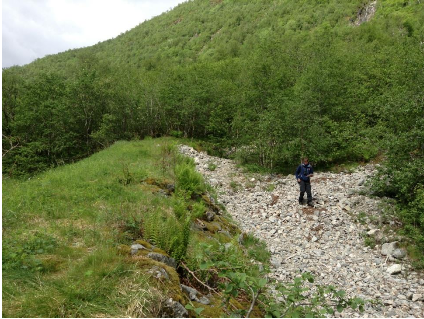
Fig. 4.5.1.2. Mindre voll som styrer det mest aktive løpet på daleviften ned til en rist og større stikkrenne unner Daleveien.
