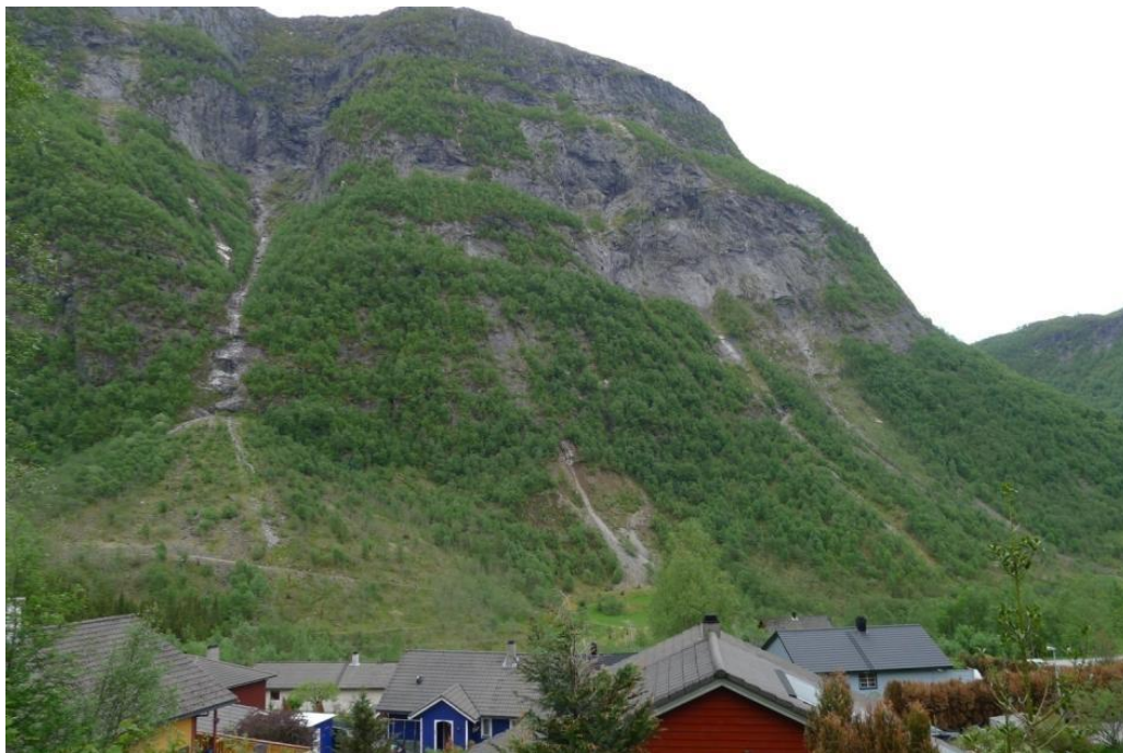
Fig. 6.5.1.11. Skredvifter langs østlige dalside, Vadheims østlige dalføre, Indredalen, sett fra bilvegen over boligfeltet under Skardshaugen. Foto: Terje H. Bargel.
