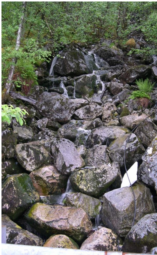
Fig. 8.5.1.4. Bekkeløpet til Vetlefossen er plastret med stor steinsprangblokk ved den øvre skogsbilveien.
