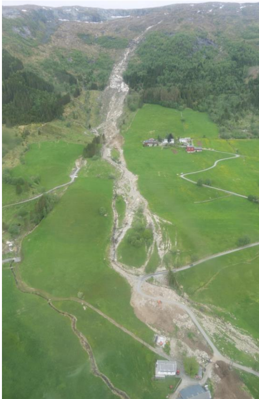
Figur 5.5.1.5 Spor etter skredet som fulgte Steinbakkkelva 2. juledag 2011.
