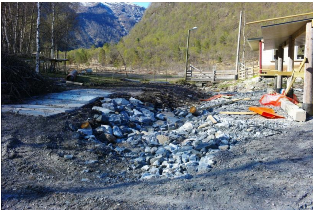
Fig. 6.5.1.8. Utløpet fra Skardsmyra et lite stykke nedenfor forrige foto. Et drensør ligger under vegen (under og til venstre for fotografen). Foto: Terje H. Bargel.
