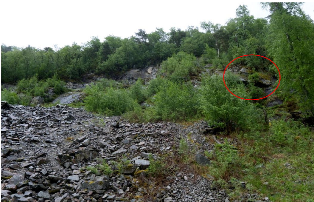
Fig. 8.4.1.5. Fjellskrent med delvis løs blokk (rød sirkel) og ur i ca. 250 m høyde.
