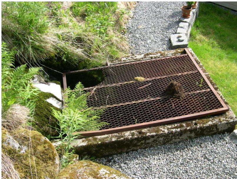
Fig. 5.5.1.8. Det vestre løpet av bekken som kommer fra Austreimslia, lagt i rør ved hus 53/148.
