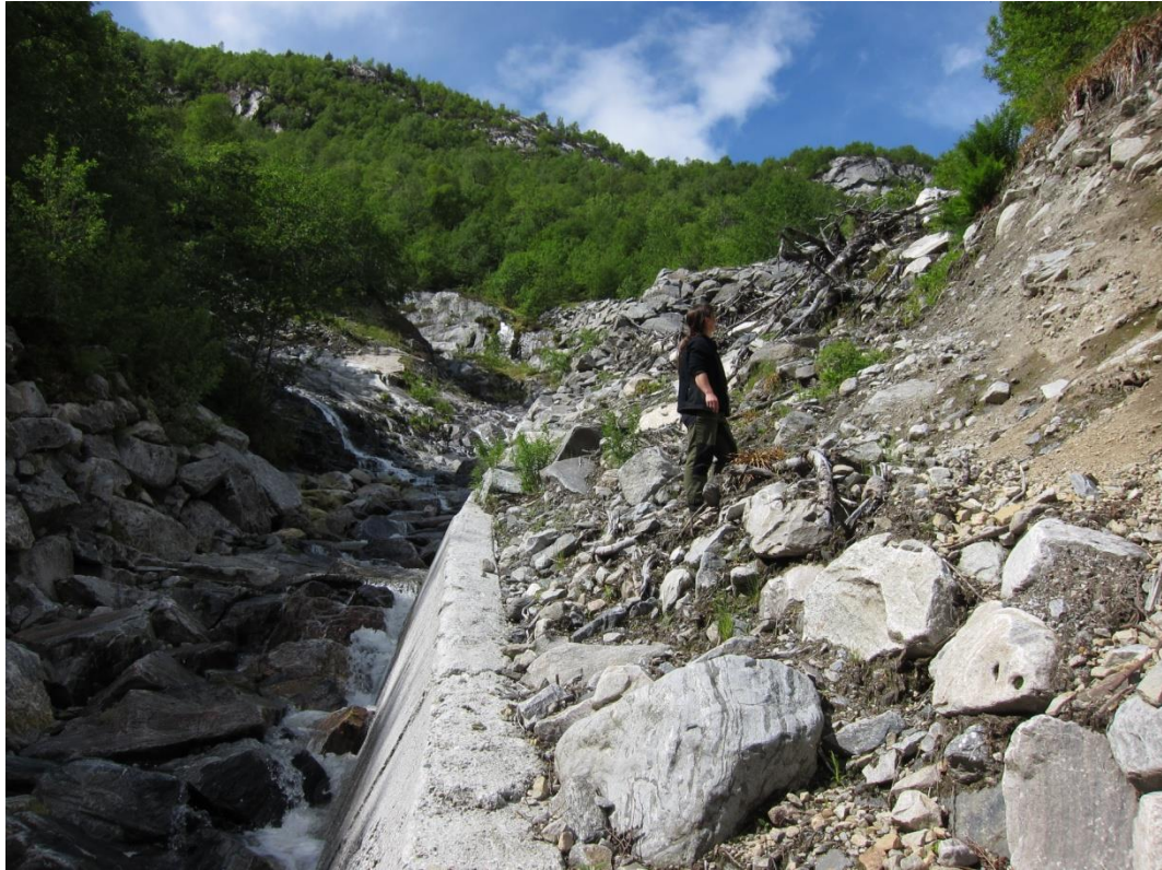
Fig. 4.5.1.7. Foto en bit opp i skredløpet ved Sandvika, med spor etter siste skredhendelse opp på ledevollen.
