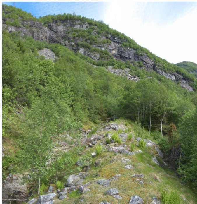
Fig. 4.4.1.6. Bilde av grøft ved den sørvestlige enden av avsetningen ved Tungerfjellet. Grøften var bygget for hindre blokker til å nå boligområdet. Det er under befaring ikke observert noe nylig steinsprang stoppet av vollen. Bilde tatt fra vest av Jaran Wasrud.
