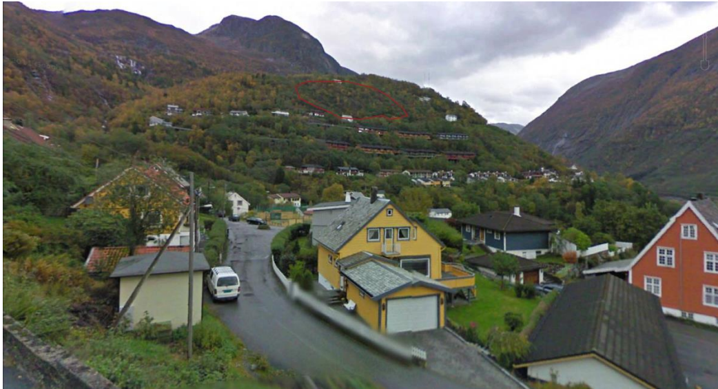
Fig. 4.4.1.7. Oversiktsbilde tatt fra vest mot skråningen ved Høgebakkene. Det er lokalisert mindre bergknauser på toppen av skråningen (rødt polygon), men disse er ikke mulig å se på bildet grunnet bergknausene er små. Flere hus er lokalisert under disse blotningene (bilde tatt fra Google Earth).
