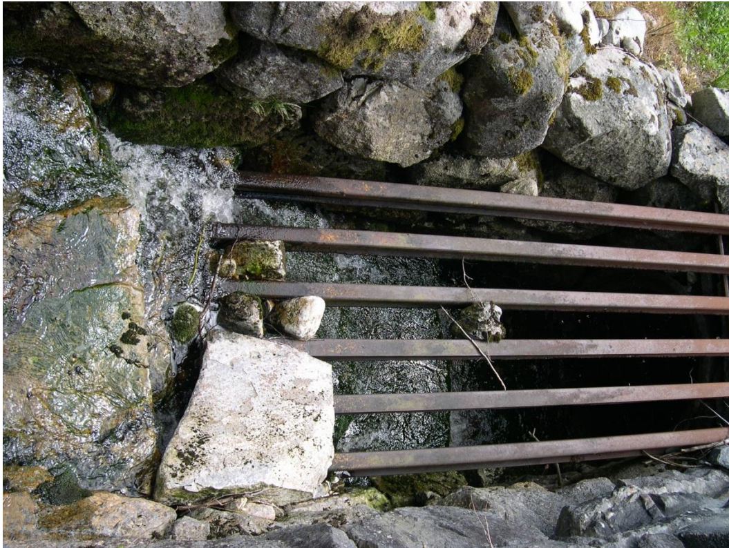
Fig. 5.5.1.10. Stein på rista der en bekk er lagt i rør rett øst for Kyrkjebø kirke.
