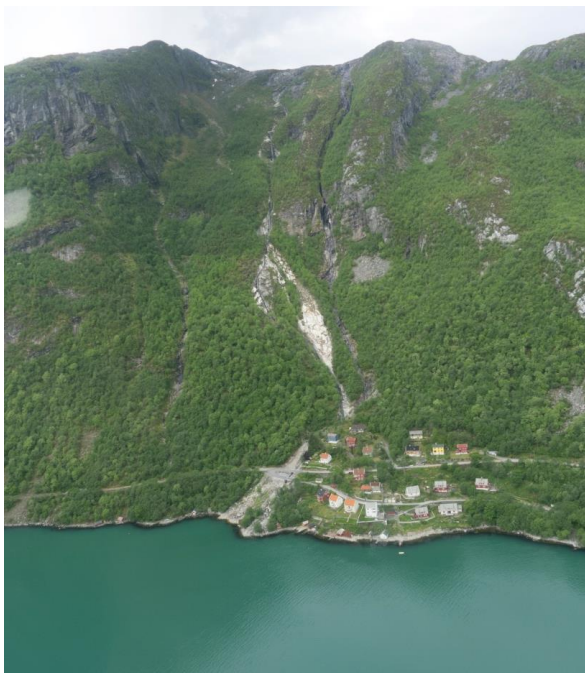
Fig. 4.5.1.5. Foto fra Helikopter over løpet og skredviftene ved Sandvika. Til høyere ned mot fjorden ses den større, eldre, bebygde delen av viften, og til venstre synes sporen av den seneste hendelsen i 2011, og den mindre aktive viften ned mot vannet.
