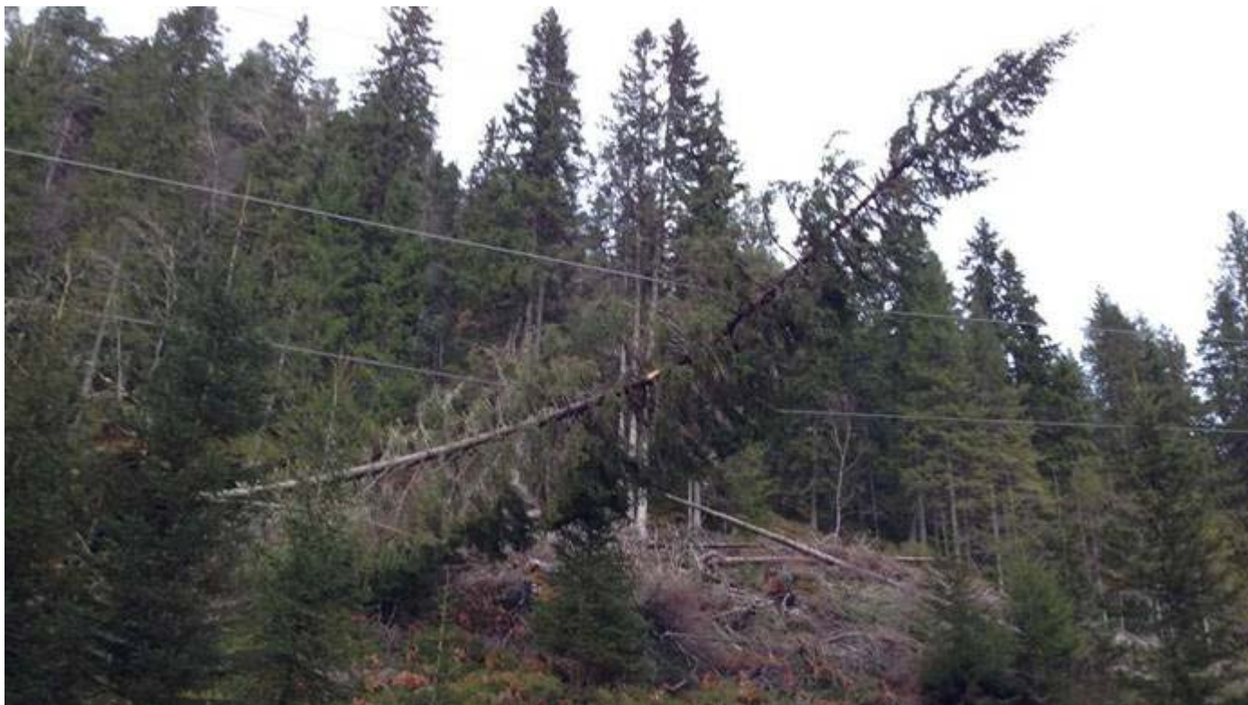
Bilde 2: Trefall på kraftledning under Hilde. Foto: NTE.
