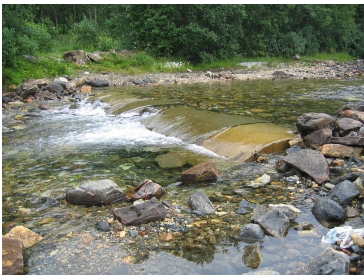
Bilde 5.2 Terskelen som beskytter kommunes hovedvannledning, foto Halvard Strand
