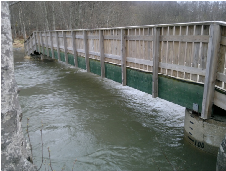
Bilde 3.2 Gangbru ved campingplassen, ved profil 11
