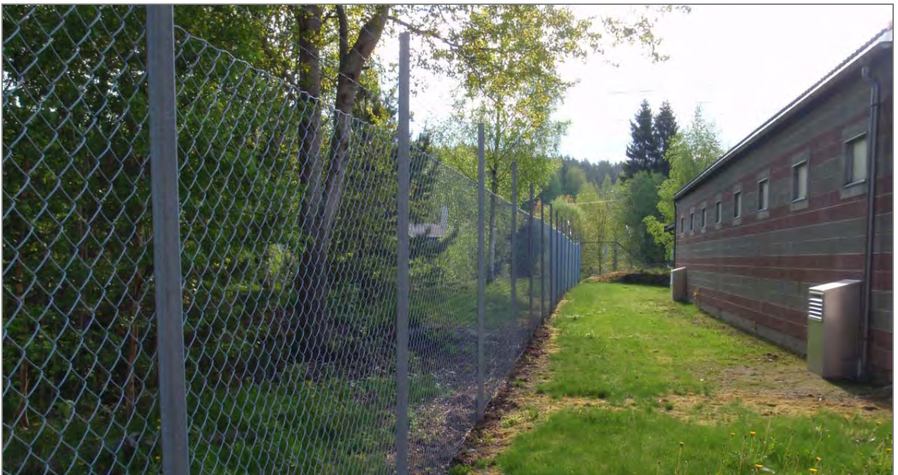
Anlegget har et 2,5 meter høyt gjerde med piggtråd.
