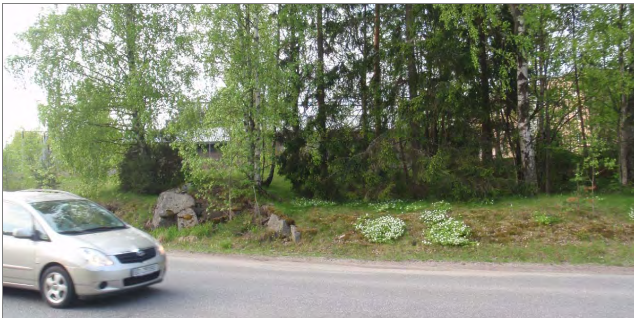
Høy vegetasjon skjermer transformatorstasjonen fra Valhallaveien.
