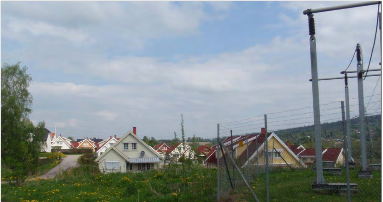
Et boligområde med eneboliger ligger rett ved transformatorstasjonen.
