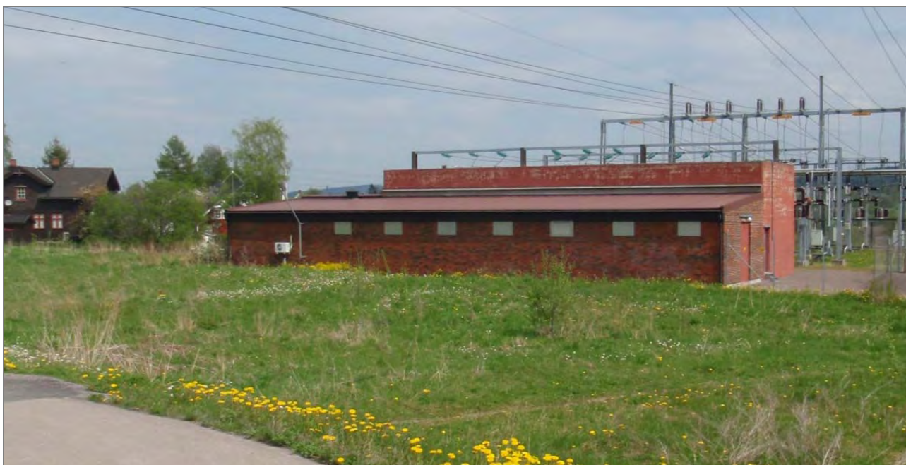
Transformatorstasjonens bygg sett fragangvei i vest.
