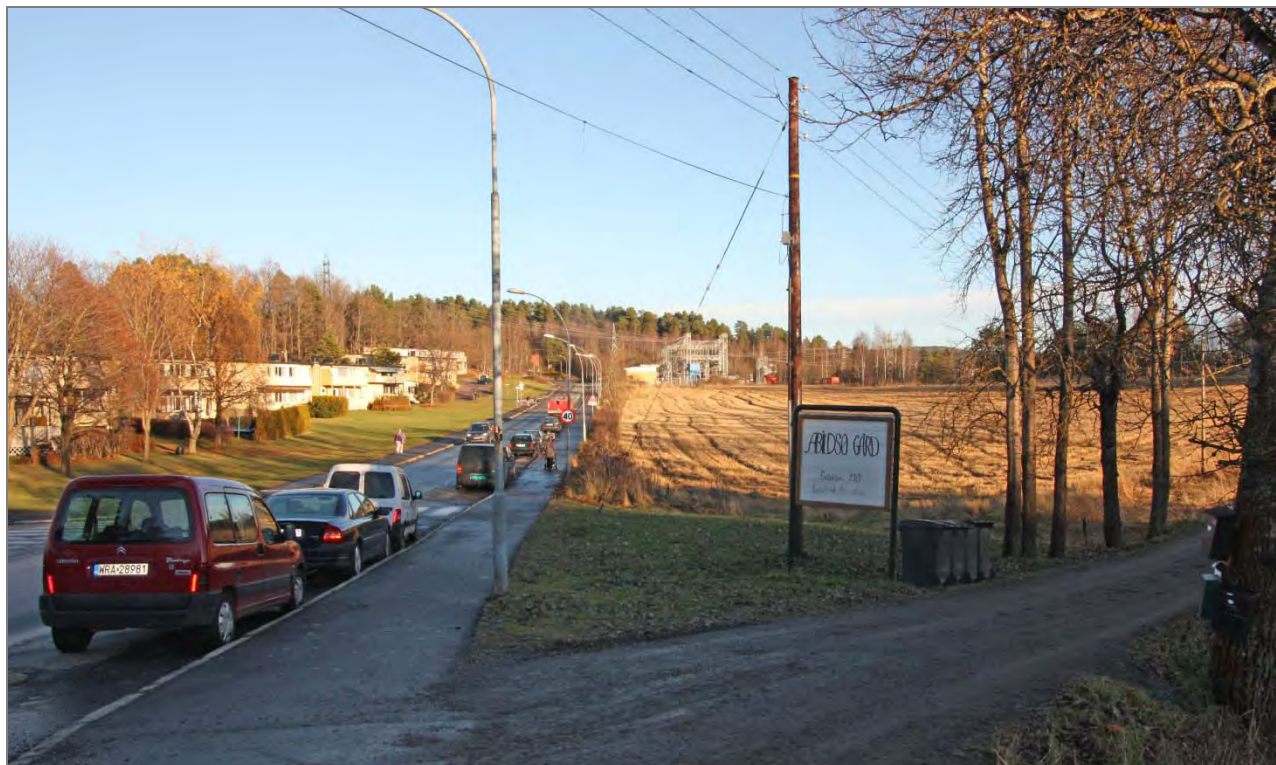
Abildsø transformatorstasjon sett fra Plogveien.
