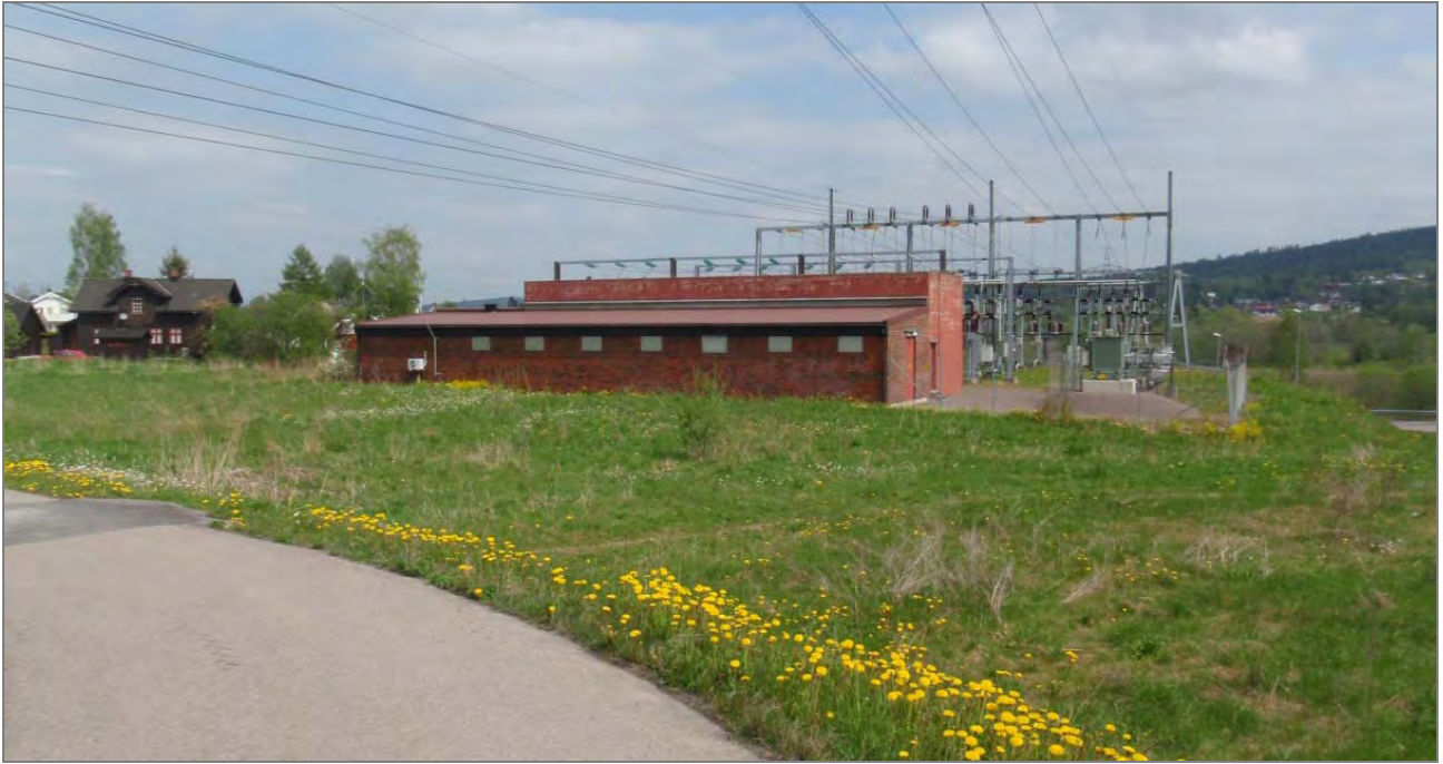
Dagens situasjon med rødfarget bygg på Leirsund transformatorstasjon.
