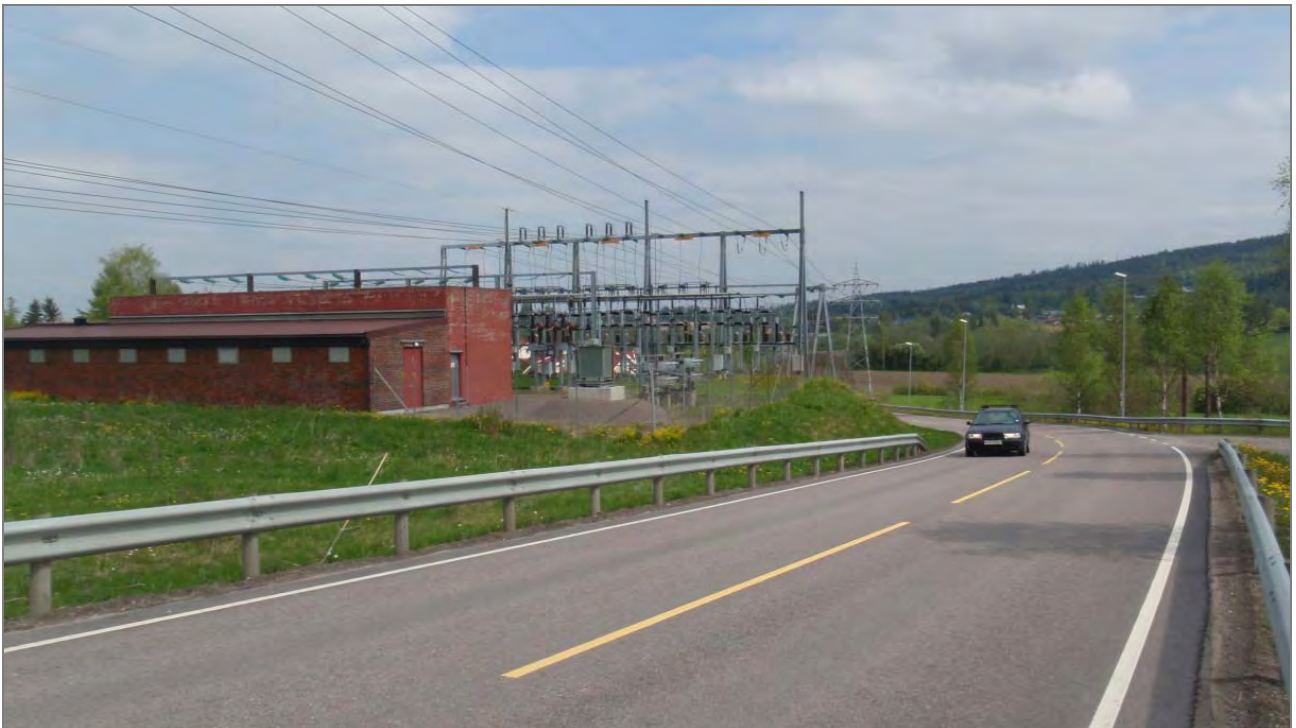
Transformatorstasjonen sett fra Rolf Olsens vei.
