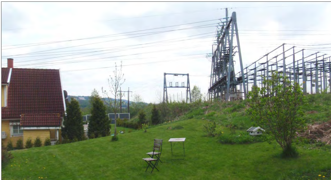
Koblingsanlegget sett fra en hage i boligområdet.
