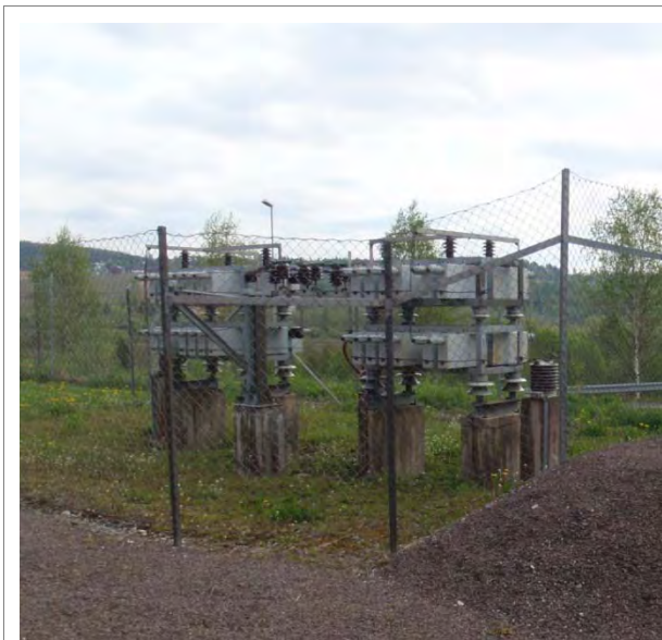
Frittstående kondensatorbatteri på Leirsund til venstre. Kondensatorbatteri på vegg ved Tårnlia
