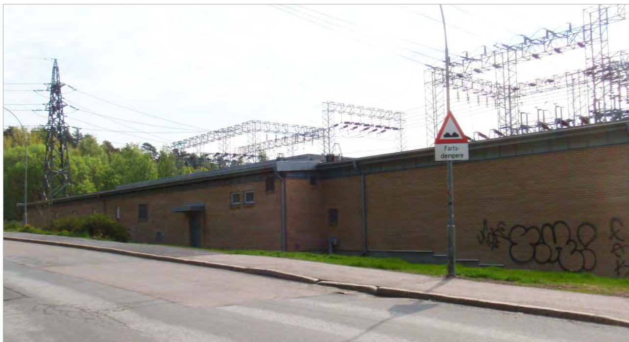
Transformatorstasjonens bygg sett fra Plogveien.
