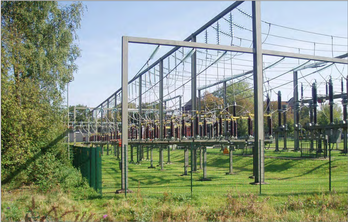
Transformatorstasjon i Ruhr-området i Tyskland. Anlegget er preget av stramme linjer og rene stålkonstruksjoner, mørke isolatorer i lavt nivå og glassisolatorer mot himmelen. Både gjerde og dekke under bryterfeltet er grønt. (Bildet er kun orienterende. I Tyskland gjelder andre krav til avstander og gjerde).
