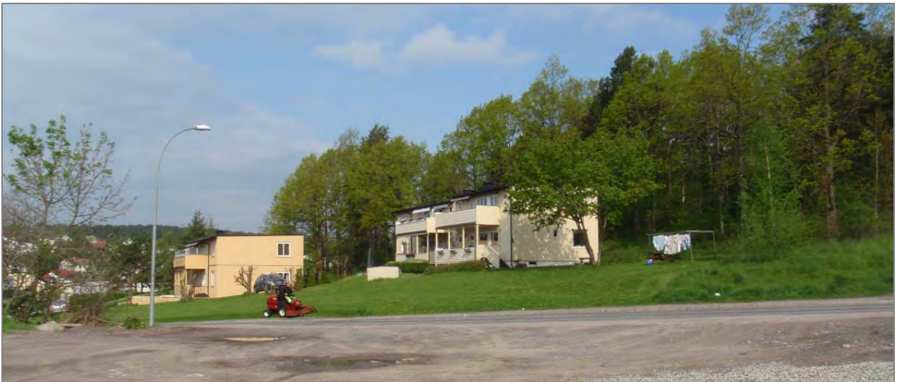
Boliger vis á vis transformatorstasjonen.
