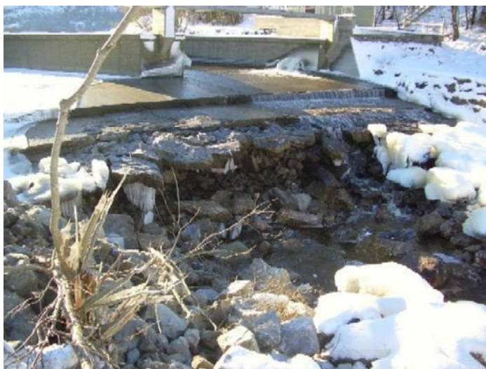
Bilde 10 Lauvsnesdammen under flommen den 2. februar kl 12.00 og erosjonsskaden i nedstrøms plastring. (foto: t.v. NVE og t.h. Sweco Grøner AS)
