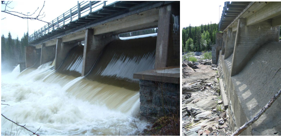
Bilde 4 Follavatn er murdam med oppstrøms tetting av betong. Veien over dammen ble stengt under flommen. Bildet til venstre er tatt den 1. februar 2006 kl. 17.00 og bildet til høyre er tatt ved inspeksjon den 20. juni 2007. (foto: t.v. Dag Bachke og t.h. Grethe Holm Midttømme).
