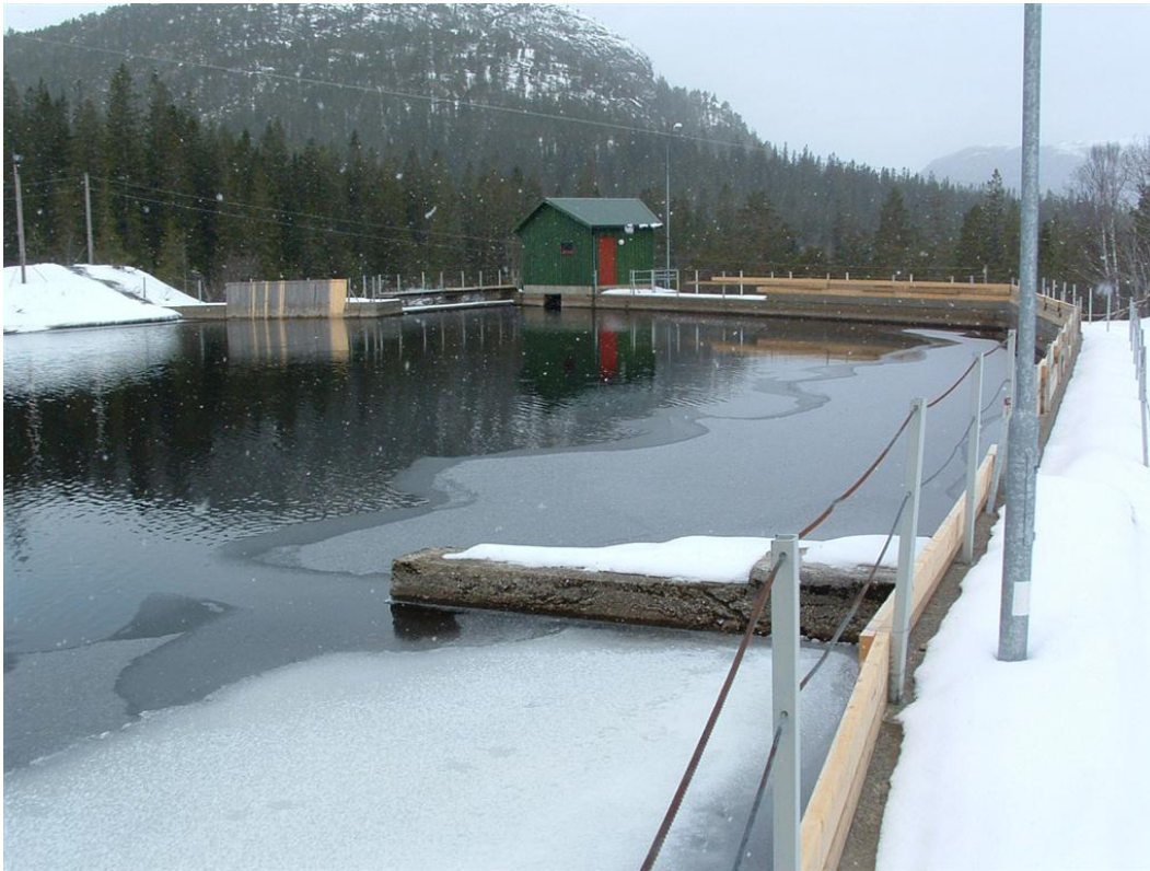
Bilde 5 Dammen som fikk forhøyet vannstand som følge av påbygging av ledemuren. Bildet er tatt 3.april 2006. (foto: Dag Bachke).
