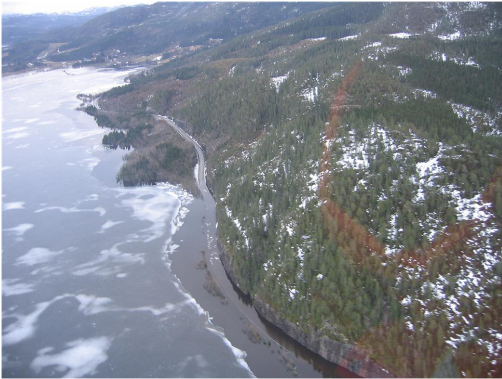
Bilde 7 Stengte veier var et problem i mange områder under flommen, som ved Eidsvatnet der bildet er tatt. Bildet er tatt 2. februar 2006 kl. 14.30. (foto: Ingebrigt Bævre).
