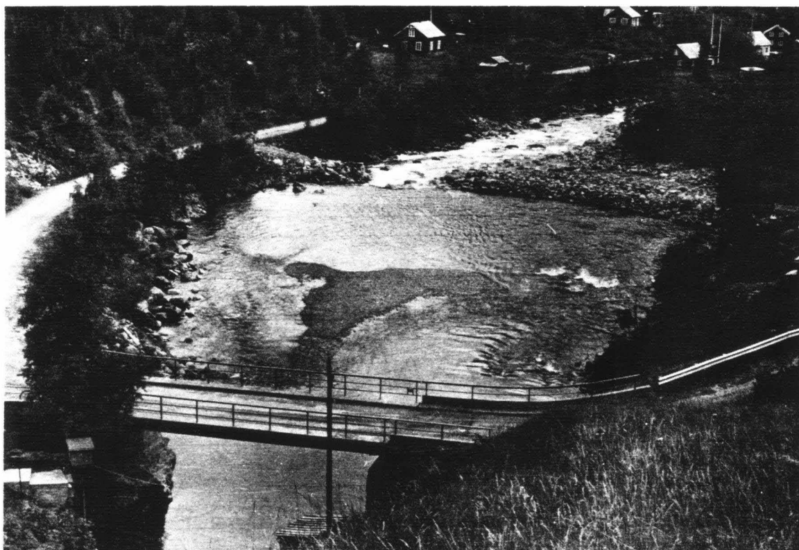
Fig. 7 Dammen i Visa nedenfor Visa bru. Bildet er tatt 30. juli 1974 mens det ennå var brudd i dammen. En bank med hovedsakelig nevestor stein har bygd seg opp i den øvre del av dammen. Limnigrafen, i forgrunnen til venstre, ble påvirket av oppdemningen.
