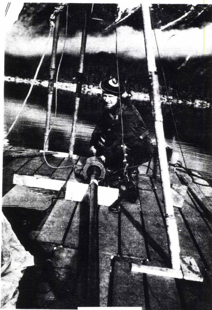
Fig. 31 Etter prøvetakingen heises stålrøret opp og legges horisontalt på flåten. Prøven trykkes deretter ut mens røret ligger i horisontal stilling. Bildet viser ing. S.R. Ekman fra Stockholms Universitet idet han foretar denne utpressingen. Merk blyloddene som er festet til rørets øverste ende.
