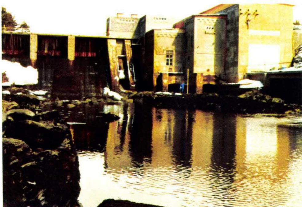
Kraftverket sett fra nedstrøms side
