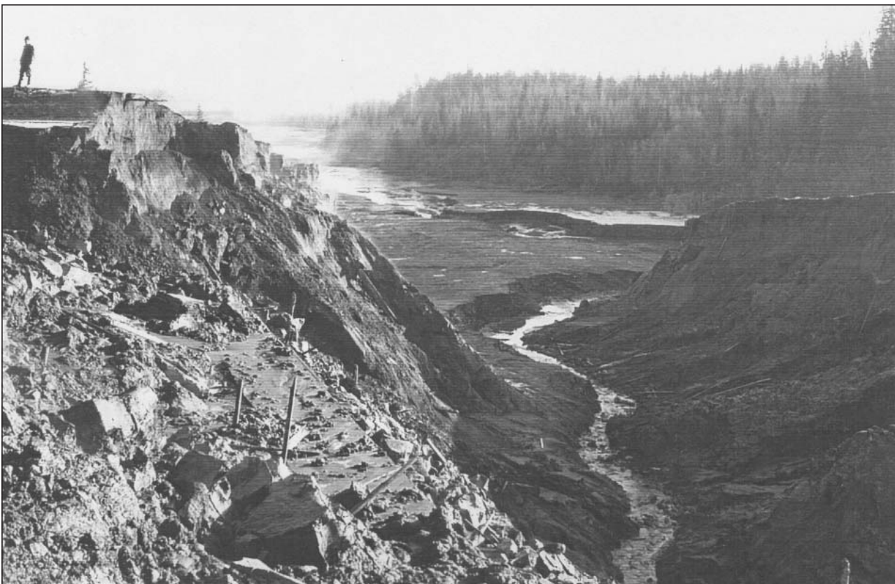
Figur 2. Uterodert gruvedeponi etter dambrudd i Saxberget.
