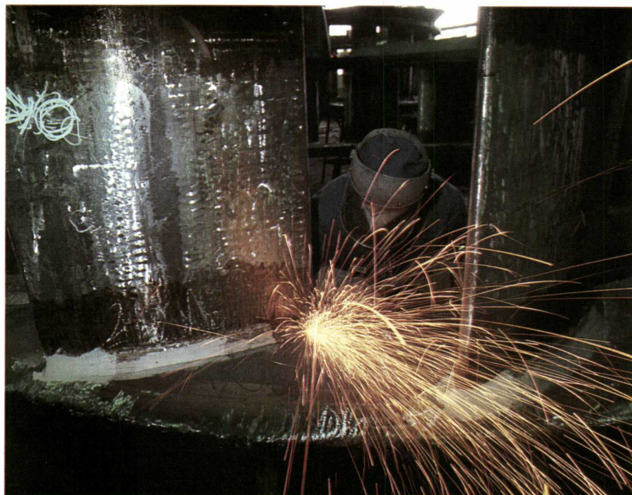
Forandringene i det norske vannkraftmarkedet kommer vesentlig raskere enn det man hadde grunn til å tro for bare et par år siden. Ved Kværner Brug arbeides det nå målbevisst for å tilpasse bedriften de nye tider. Foto: Per Anders Rosenkvist/Samfoto.
