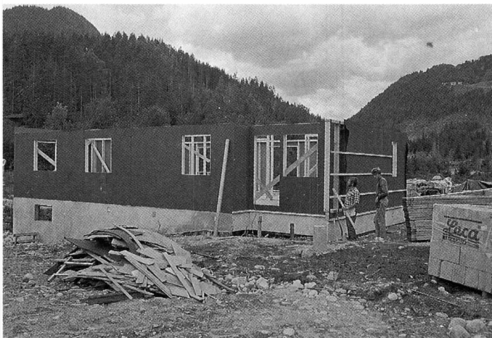
Veggene er reist. Taket står for tur. Det er langt frem.
