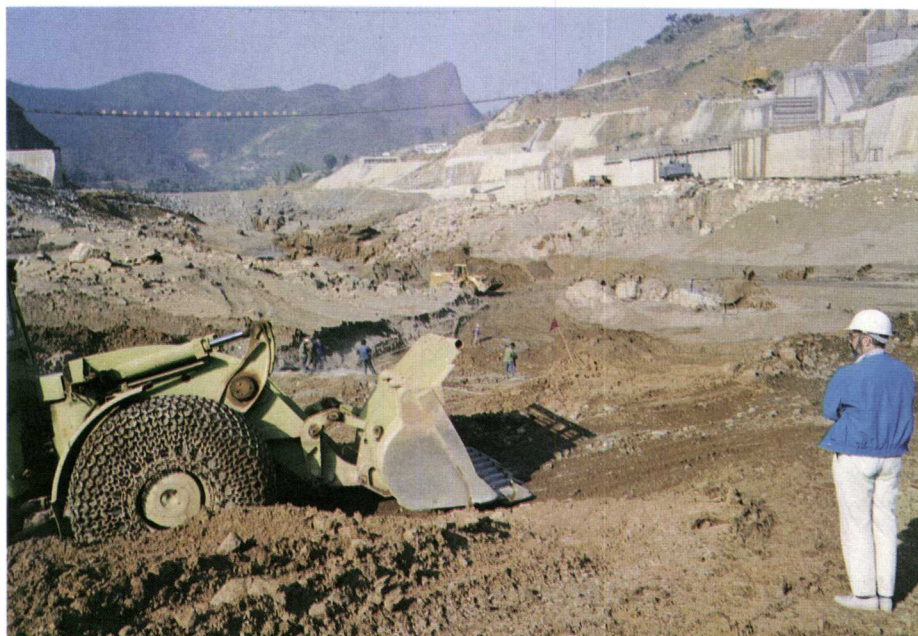
Ved Yantan-anlegget er nå utsprenningen omtrent ferdig og de første støpearbeider i gang. Fangdammene ble ferdig i vår etter at 300 000 kubikkmeter valsebetong var innstoppet på vel tre måneder. Maksimum på ett døgn var 8 000 kubikkmeter. Bildet viser damområdet etter tørlegging.
