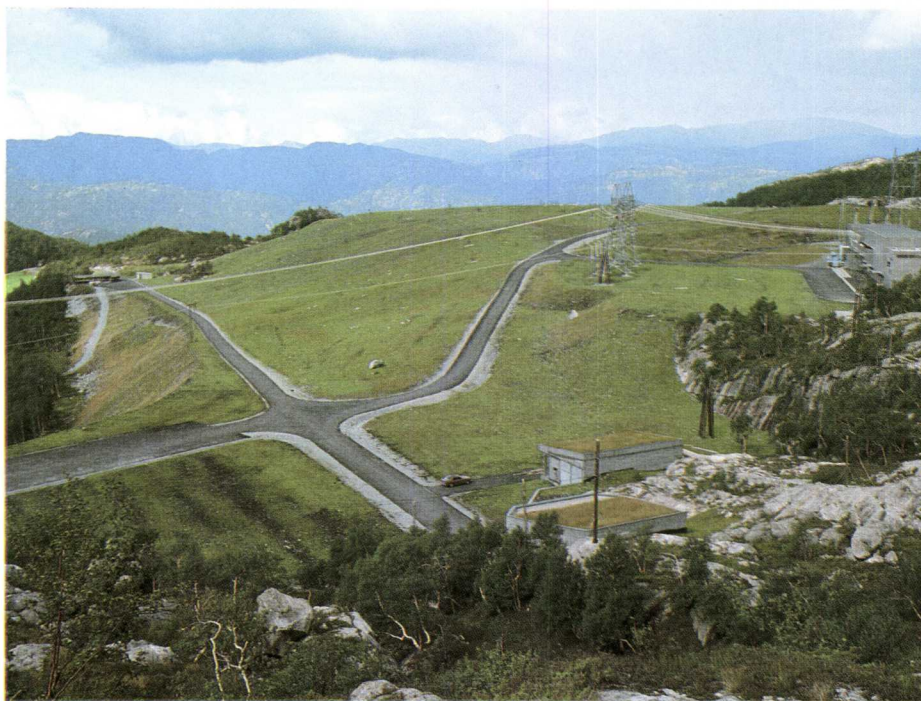
Før: I oktober 1980 såg riggplassen ved Saurdal kraftstasjon slik ut. Foto: Jostein Granli.
