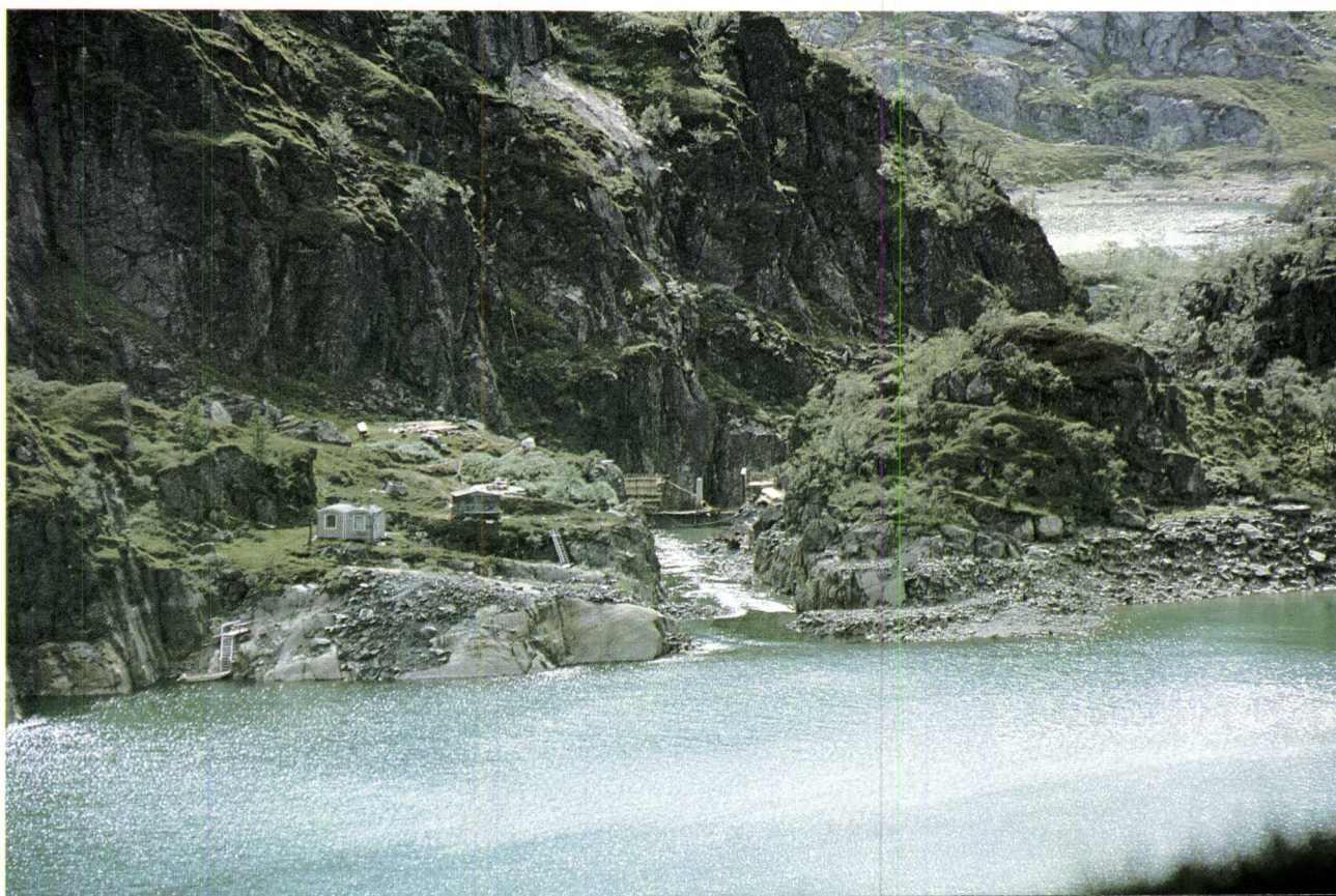
På nedre Moen pågår arbeidet med sperredammen som skal gjera det mogleg å heva Moavatnet 7–8 meter opp til det gamle nivået.
