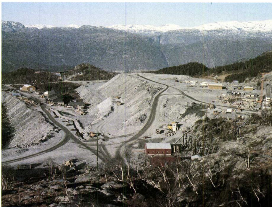
Nå: Riggplassen ved Saurdal kraftstasjon i august 1988.
