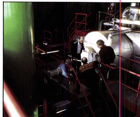
Driftsleder Einar Ohm demonstrerer hvordan vannstand og trykk i kjelene overvåkes. Gjennom den grønne trakten til venstre føres forbrenningsluft til fyrrømmet.
