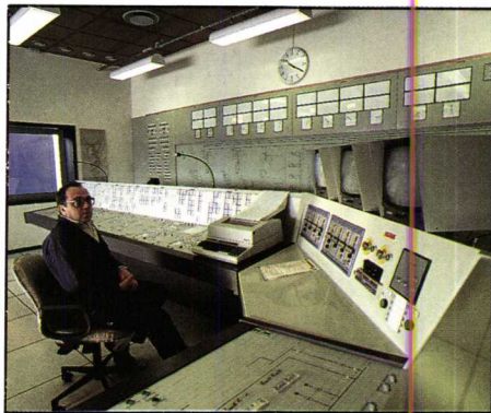
Kraftverket fjernstyres fra kontrollrommet. To ansatte er alltid på vakt — én i kontrollrommet og én ute i anlegget. De har kontakt med hverandre over radio.
