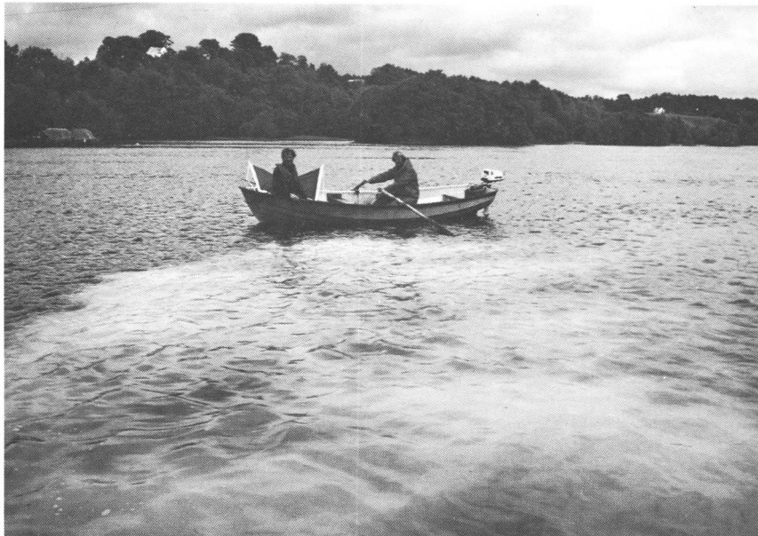
Luft fra det overmettede vannet i Nidelva unnslipper som gassbobler. I det melkehvite vannet som sees på bildet er metningen ca. 80 prosent høyere enn normalt.
