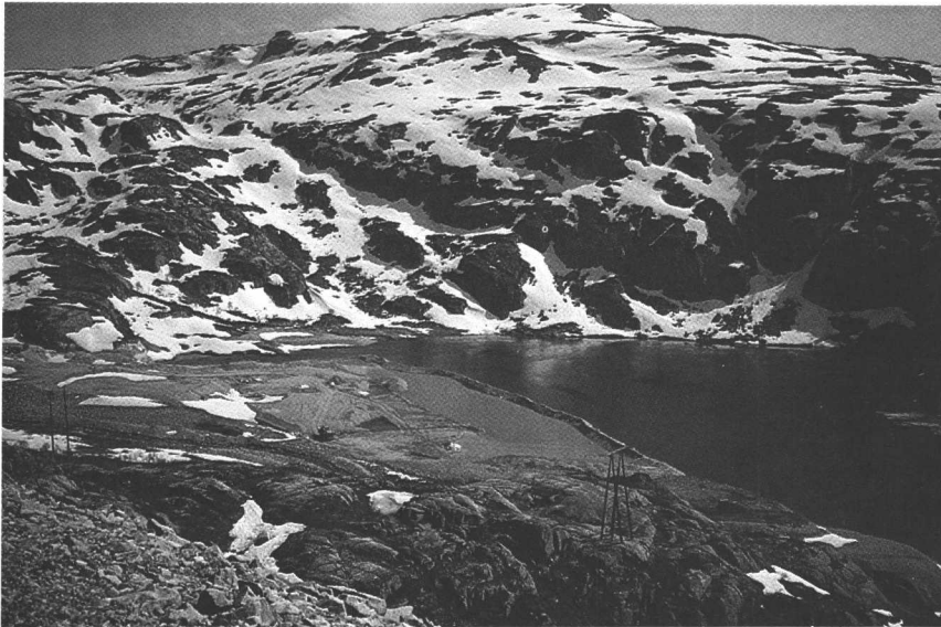
Fra pressebefaringen på Ulla-Førre 2. juni: For at grustaket på Nedre Moen ikke skal forurense Ulladalsåna går avløpet gjennom et slambasseng før utløpet i Moavatnet.
