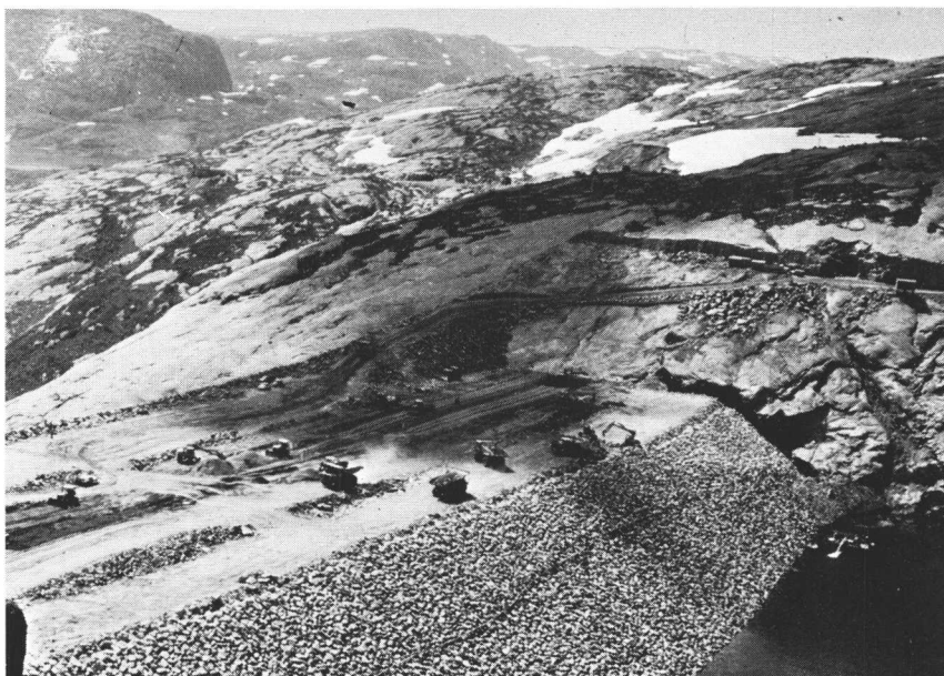
Svartevannsdammen under bygging. Damhøyde 128 meter.
