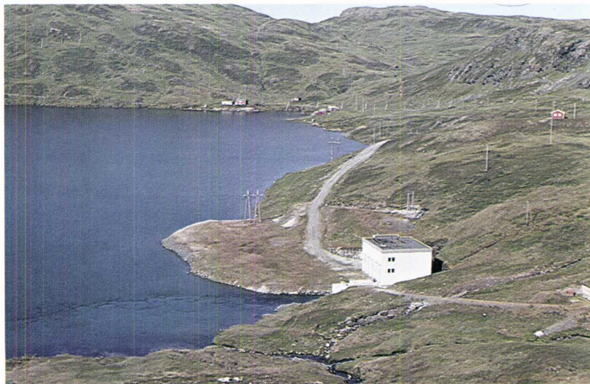
De signalledninger man ser på dette bildet av stasjonsområdet ved Målset kraftverk, er nå erstattet med kabel.
