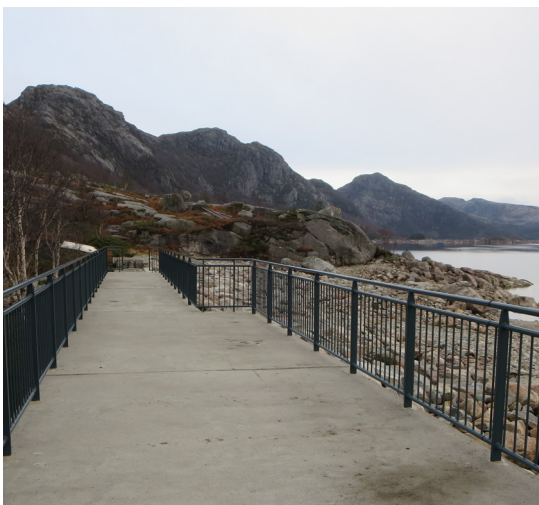
Rekkverk. Foto: Jan Henning L'Abée-Lund.
