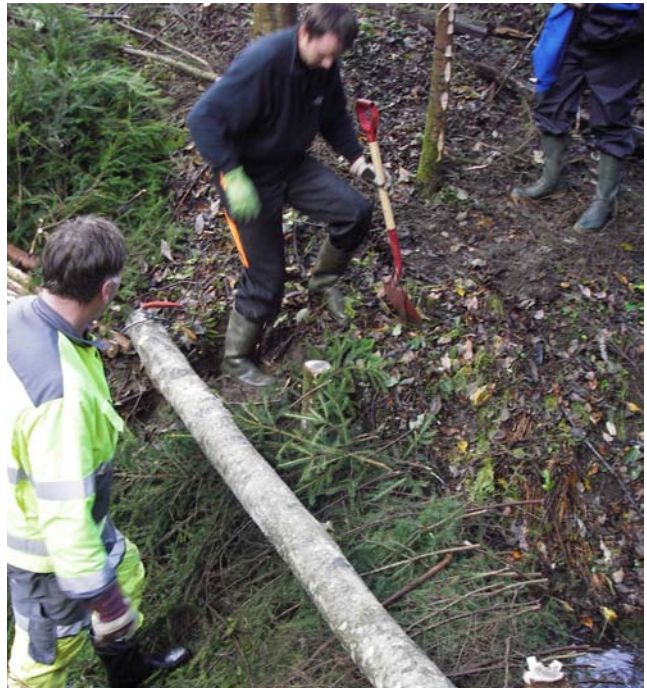
Bilde 3. Toppstokken legges på, forankres i sidekantene og festes til støttestokkene.
