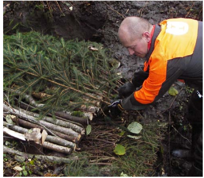
Bilde 2. Kvister legges over tverrstokken på en liten kvistdam i 3. «trappetrinn».
