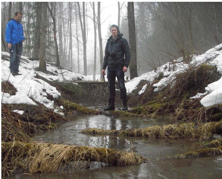
Bilde 5. Kvistdammen i bakgrunnen har fanget opp sedimenter første vinteren/våren etter anlegging.
