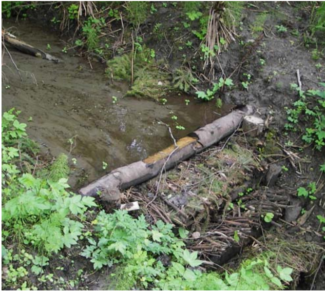
Bilde 1: Liten kvistdam i erosjonsrenne, fylt med sediment. (Foto: Michal Kravcik).
