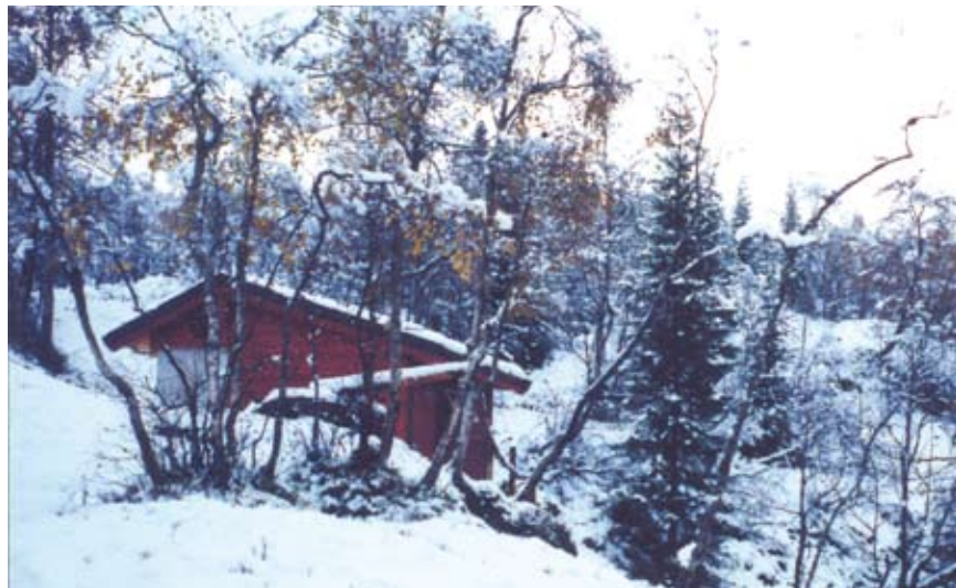
Kraftstasjonen på Gjerland, i sideelv til Gaularvassdraget, er lagd godt inn i terrenget og den har fått ein enkel arkitektur som harmonerer med bruken av bygget.
