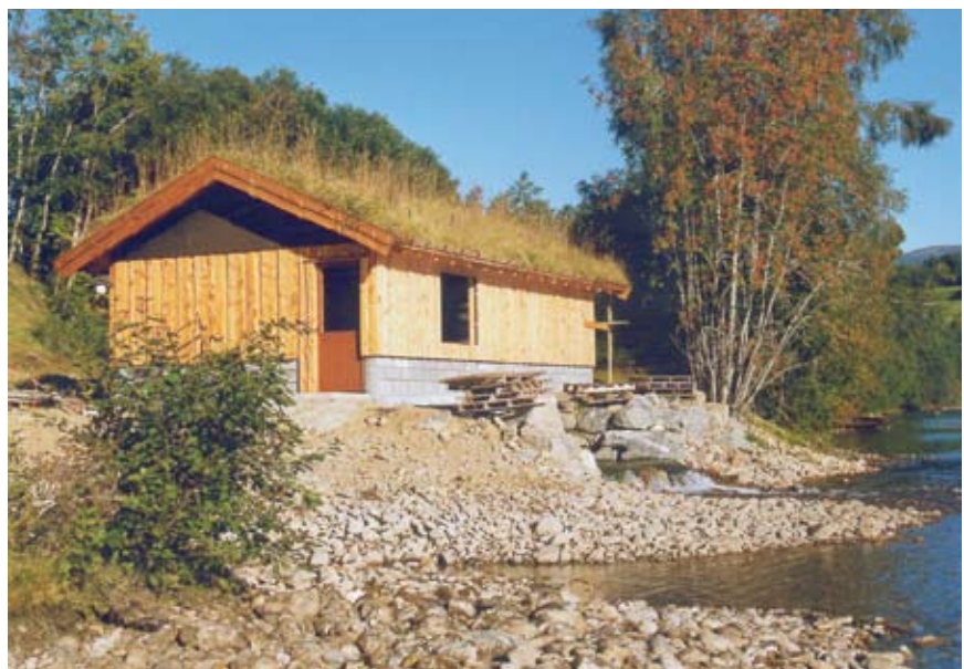
Kraftstasjonen på Søreide, Breimsvassdraget, med villmarkspanel og torvtak.
