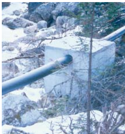
Røygate som er forankra på betongfundament, minikraftverket i Ullensvang
