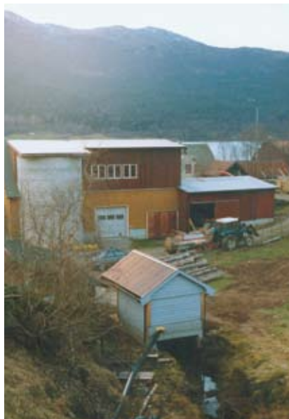
Mikrokraftverk på Hestad, i eit sidevassdrag til Gaularvassdraget: Kraftstasjonen er eit lite bygg som er plassert i tunet bak dei andre husa.
