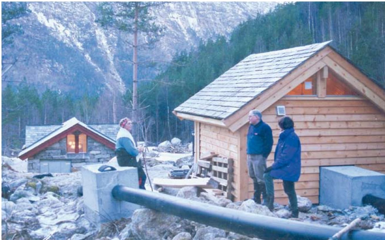
Minikraftverk i Ullensvang: Kraftstasjonsbygga i tre og stein har fått ei god utforming.
