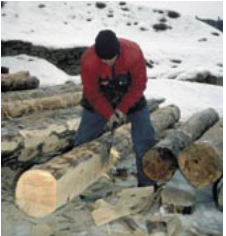
Arbeid med restaurering av elveforbygningen i Hitterelva på Røros i Sør-Trøndelag. Foto: Rørosmuseet
