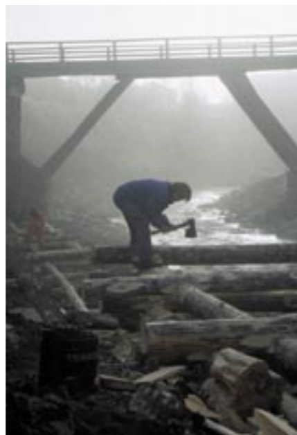
Restaurering av tømmerkister i Hitterelva på Røros i åra 1994 til 2000. Foto: Røros-museet
