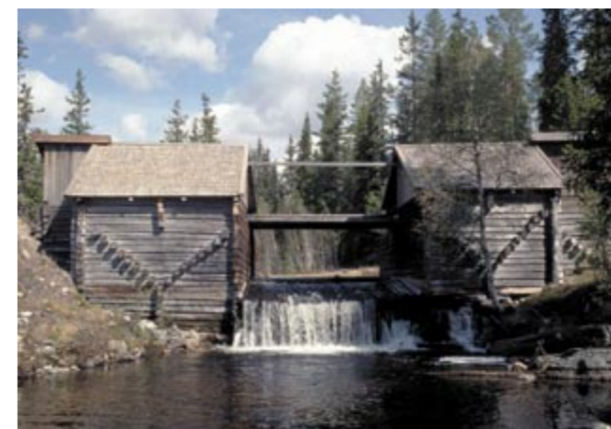
Fiskvikrokkdammen i elva Rokka, Rendalen i Hedmark er en godt bevart tømmerkistedam. De steinfylte kistene har takoverbygning. Under takene ble fløtingsutstyr og stengeanordninger til dammen lagret. Bru over dammen sikret gode arbeidsforhold når dammen skulle settes, og tjente som tverrforbindelse over elva. Foto: Einar Engen, privat arkiv.
