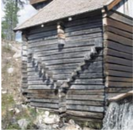
Bildet viser tverrstokkene laftet inn i de langsgående veggene i et av landkarene slik at de danner V-form. Disse kistene ble fylt med stein. Fiskvikrokddammen i elva Rokka, Rendalen, Hedmark. Foto: Einar Engen, privat arkiv.
