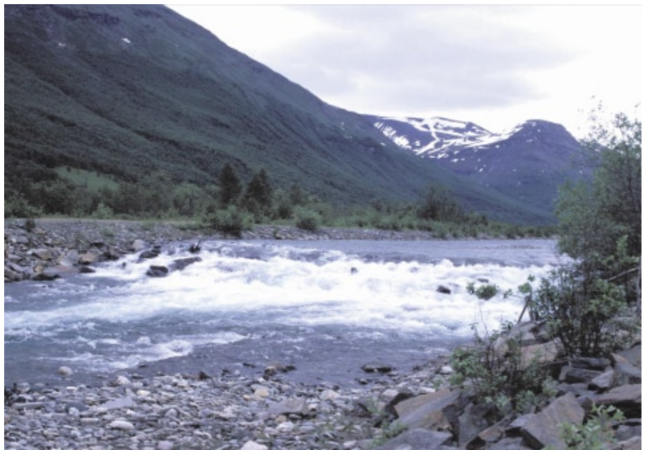
Eksisterende terskel TE8 ved Moski
