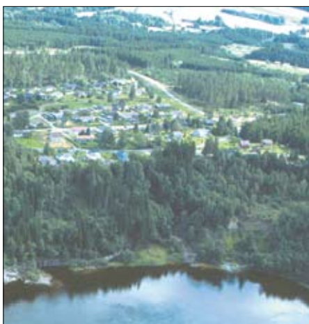
Boligfeltet i Hvitvingfoss, Kongsberg kommune. Boligfeltet ligger på en kvikkleiresone. Etter flere ras på skrenten mot Numedalslågen og evakuering av husstander, ble skrenten sikret høsten 2001. Foto: S. Dahlgren
