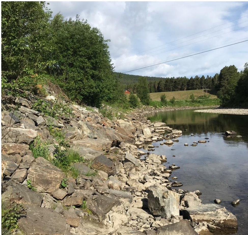
Figur 8: Erosjonssikring, ved parsell 1, ved Tunna ovf. Riksvegen. (Bilde: Multiconsult)
