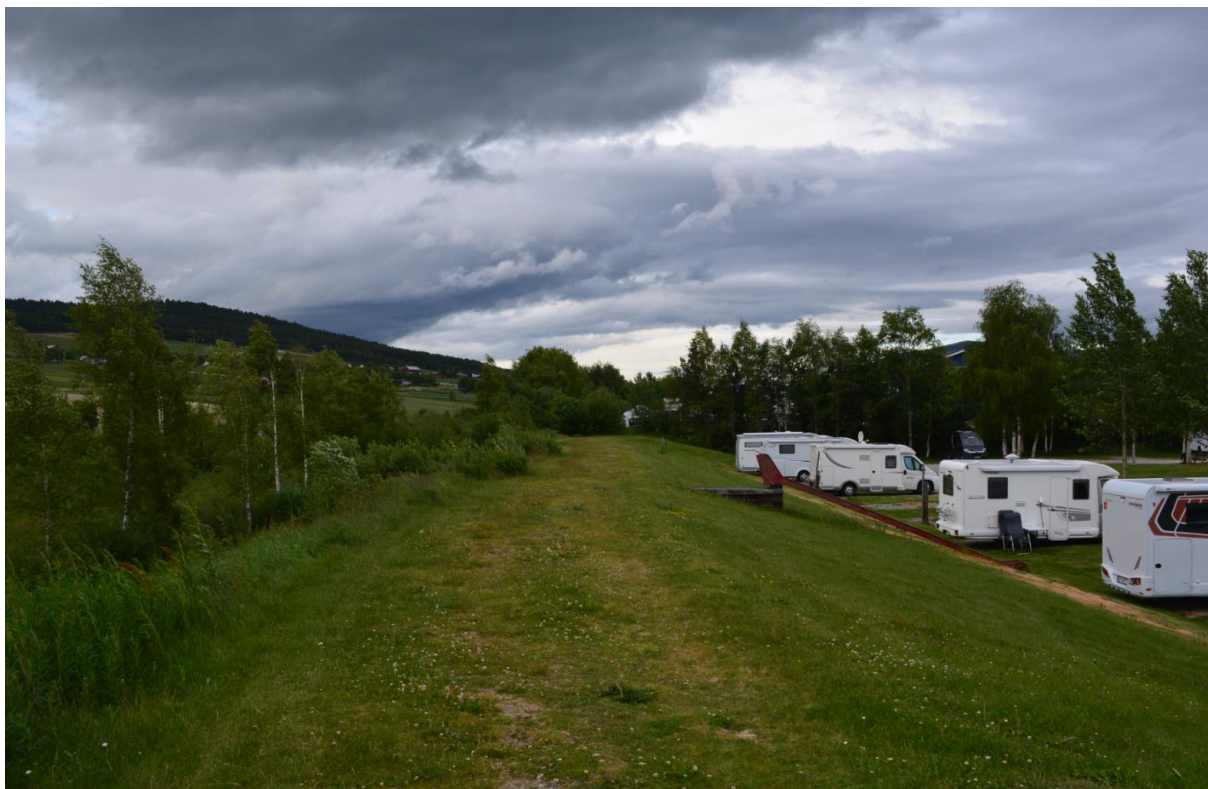
Figur 8: Oversiktsbilde over flomverket. Sett fra pel nr. 110 mot nordøst (Bilde: Multiconsult)
