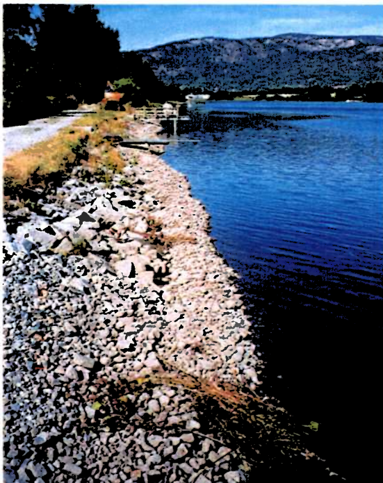
Parsell 5a. Bildet viser strandsona slik den så ut rett før anleggsarbeidet startet opp (23. august 1999)
