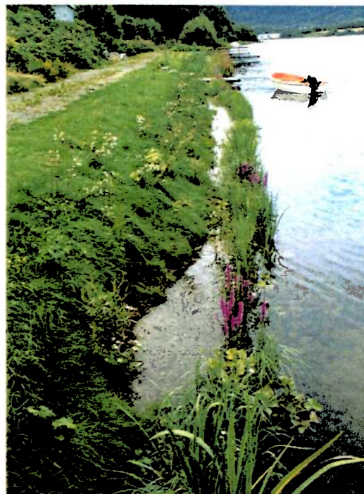
Parsell 5a. Samme strekning som bildet til venstre ca 1 år etter at anlegget ble utført (24. august 2000). Kokosmatta er sterkt svekket og dette har trolig vært gunstig for grastilslaget (jf. bildet vedlegg C3)
