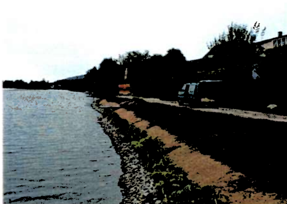
Parsell 4. Anleggsarbeidene er nylig avsluttet (26. august 1999)
