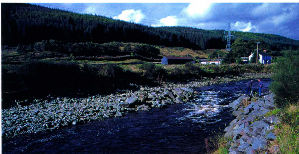
Det nykonstruerte elveleiet i Evan Water. Personene står ved en av de store strømkonsentratorene som bidrar til å holde den store kulpen ren og skape en variasjon i strømhastigheten.
