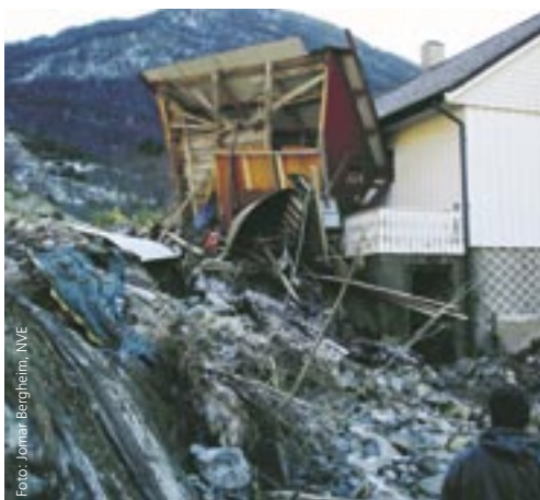
Evakuert hus ved Materselvo i Hordaland
