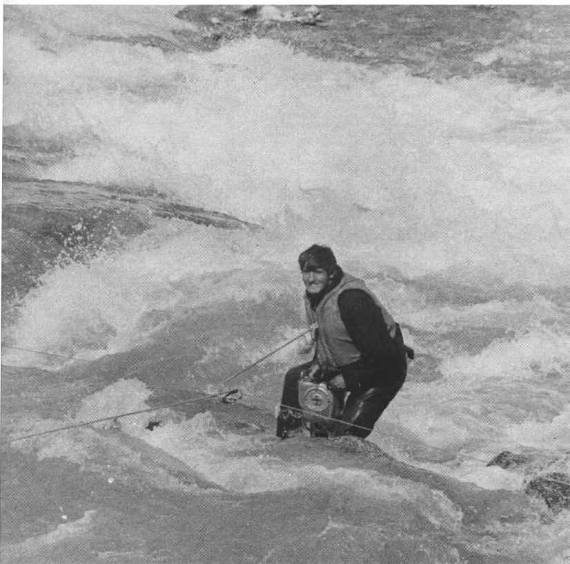
Motorboring foran Nigardsbreen for å få laget fundament for måleinnretning.
