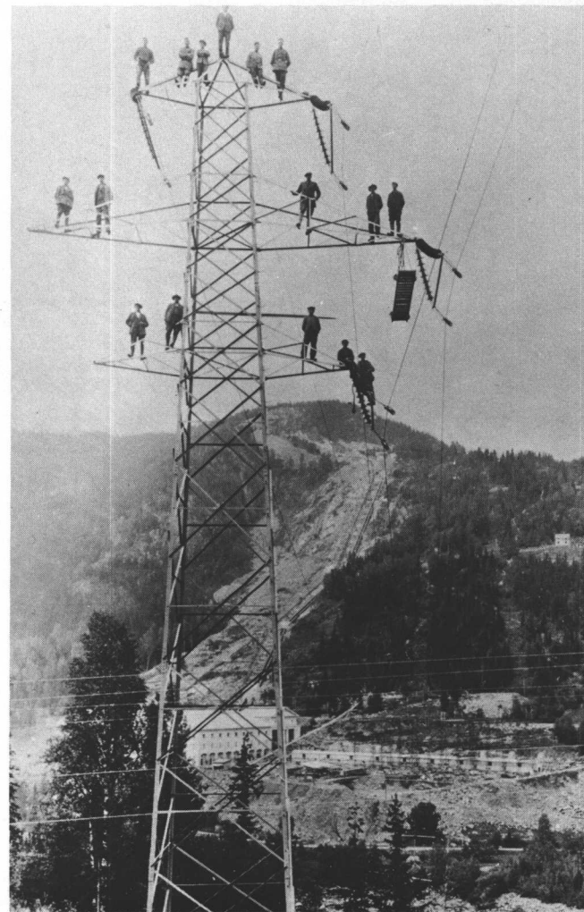
Numedalslinjen med Nore kraftverk i bakgrunnen fra utbyggingstiden i 1920-årene.
